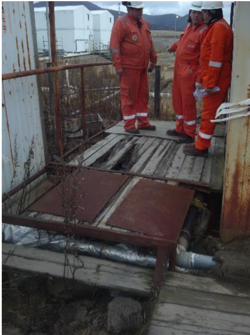
Фото 1. Зброшенныя збудаванні ўблізі УОСВ
