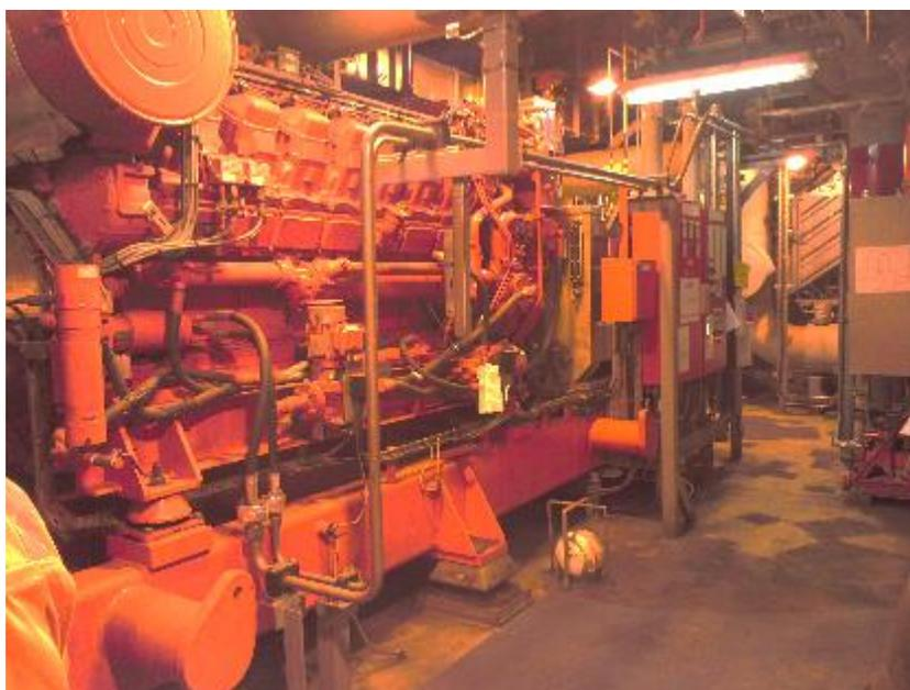
**Фото 12.** Один из двух (дизельных) насосов пожарной воды
