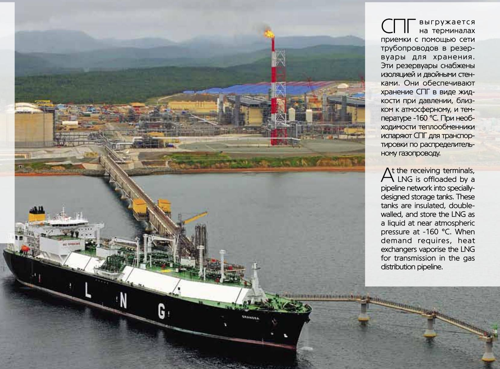
СПГ выгружается на терминалах приемы с помощью сети трубопроводов в резервуары для хранения. Эти резервуары снабжены изоляцией и двойными стенками. Они обеспечивают хранение СПГ в виде жидкости при давлении, близком к атмосферному, и температуре  $-160^{\circ}\text{C}$ . При необходимости теплообменники испаряют СПГ для транспортировки по распределительному газопроводу.
