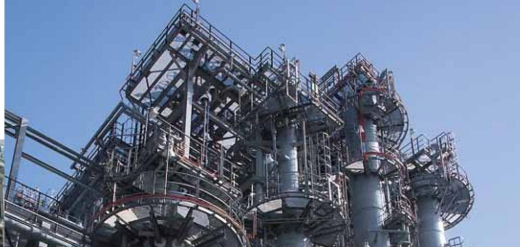
Вторая технологическая операция — это удаление тяжелых углеводородов или легкого конденсата в газодробной установке. При необходимости также удаляются пропан и бутан или сжиженный нефтяной газ (СНГ).
