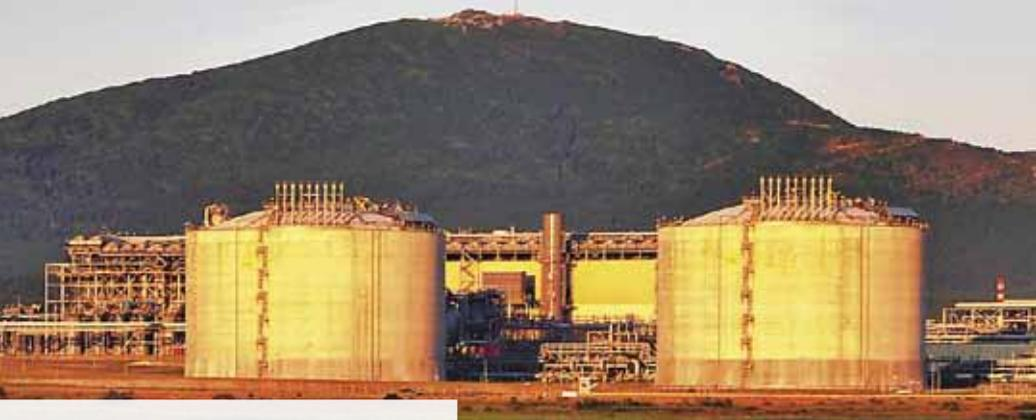
Резервуары СПГ рассчитаны на низкие давления и оснащены предохранительными разгрузочными клапанами, настроенными на подъем при давлении приблизительно 0,25 бар (3,6 фунта/кв. дюйм). Давление в судовых и береговых резервуарах обычно поддерживается ниже этого уровня.
