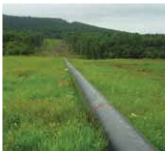
Сенокос, занятый под строительство трубопроводов, с. Воскресеновка
