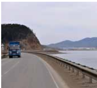
Реконструированная дорога в районе ПК «Пригородное»
