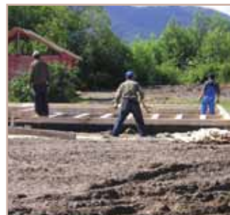
Строительство дома для переселяемой семьи, с. Фирсово
