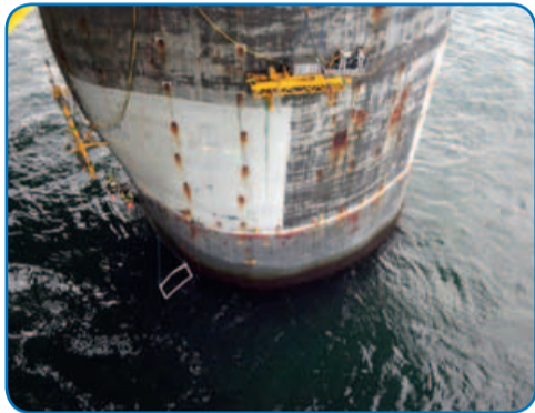
Работы на одной из опор основания платформы ПА-Б
