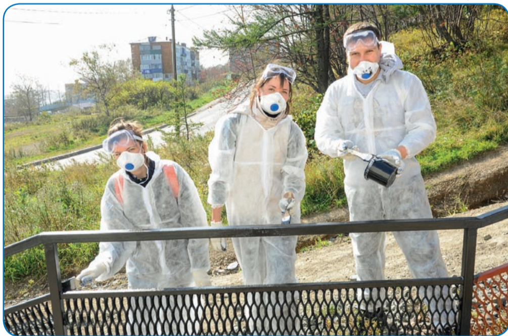
Во время акции волонтеры покрасили перила на лестнице протяженностью более 130 метров, установленные при поддержке компании During the eco-event volunteers painted a new 130-meter-long railing of the stairs. The handrails were installed with the support of the company
