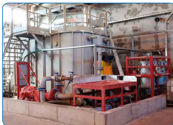
Результат проекта модернизации завода по приготовлению буровых растворов
