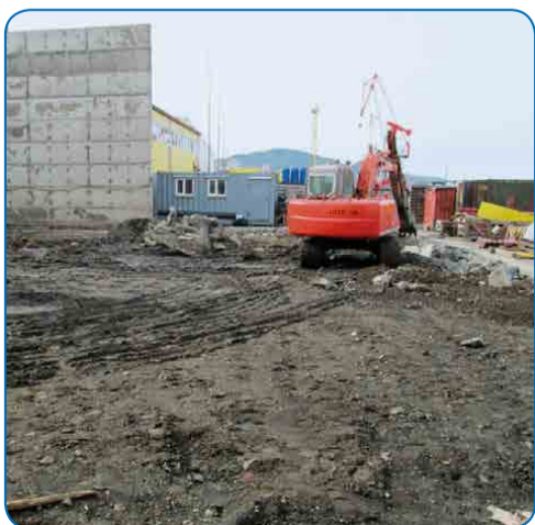
Начало проекта модернизации завода по приготовлению буровых растворов
