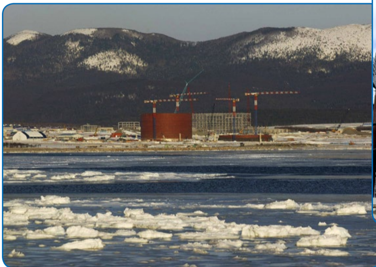
Строительство резервуаров для хранения СПГ, 2006 год LNG tanks construction, 2006
