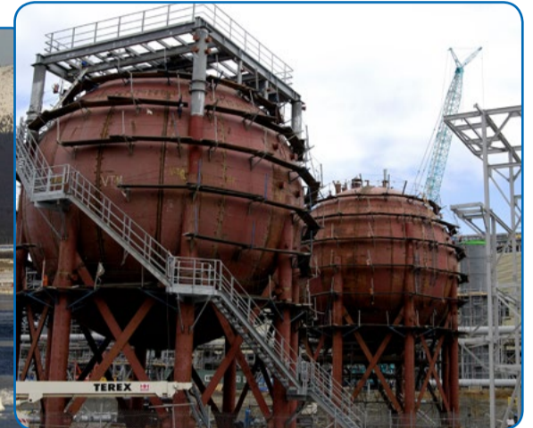
Строительство сфер для хранения хладагента, 2006 год Construction of spheres for refrigerant, 2006
