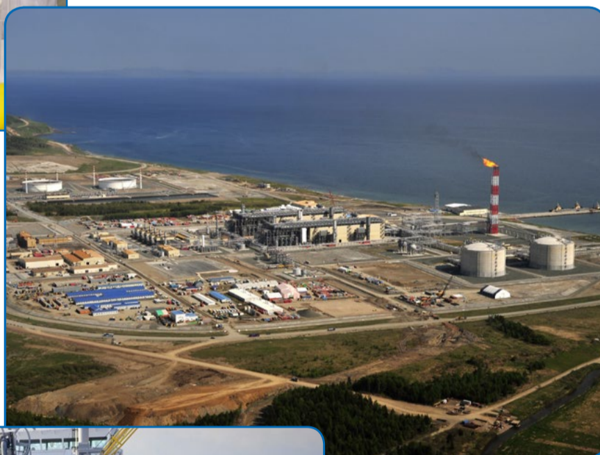
Строительство завода СПГ, 2008 год LNG plant construction, 2008
