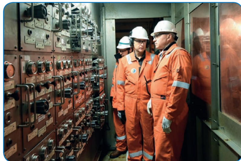
Проверка готовности оборудования к работе в осенне-зимний период
