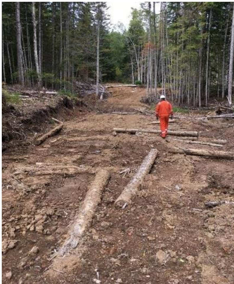
Фото 34. Подъездная дорога к НКС-3.
