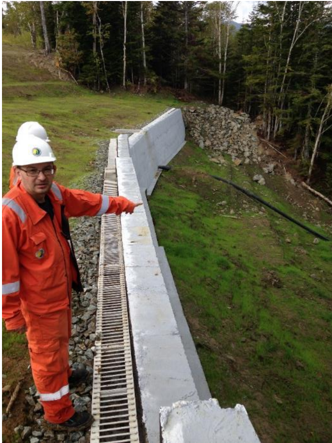
Фото 7. Укрепленная железобетонная подпорная стена, недавно установленная на КП 383.4.
