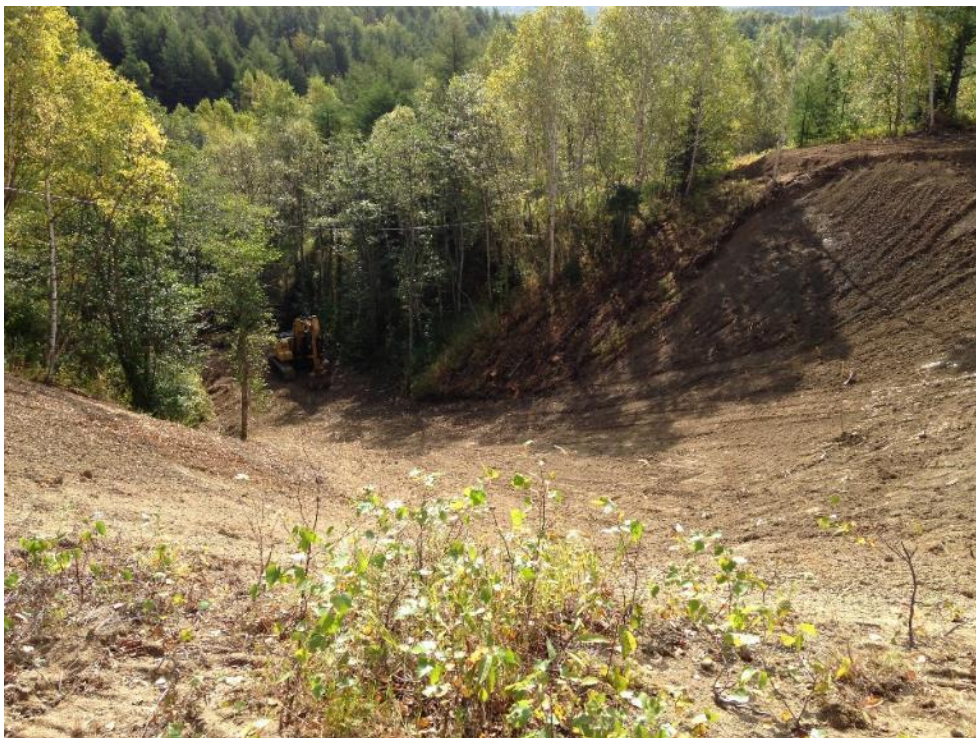
Фото 8. Восстановленный склон на КП 449 при подготовке к установке грунтовых якорей и сетки.
