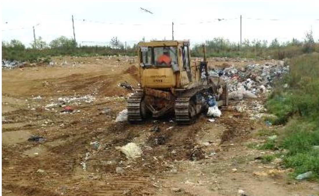
Фото 16. Работы по уплотнению и покрытию отходов в секции «Сахалин Энерджи».
