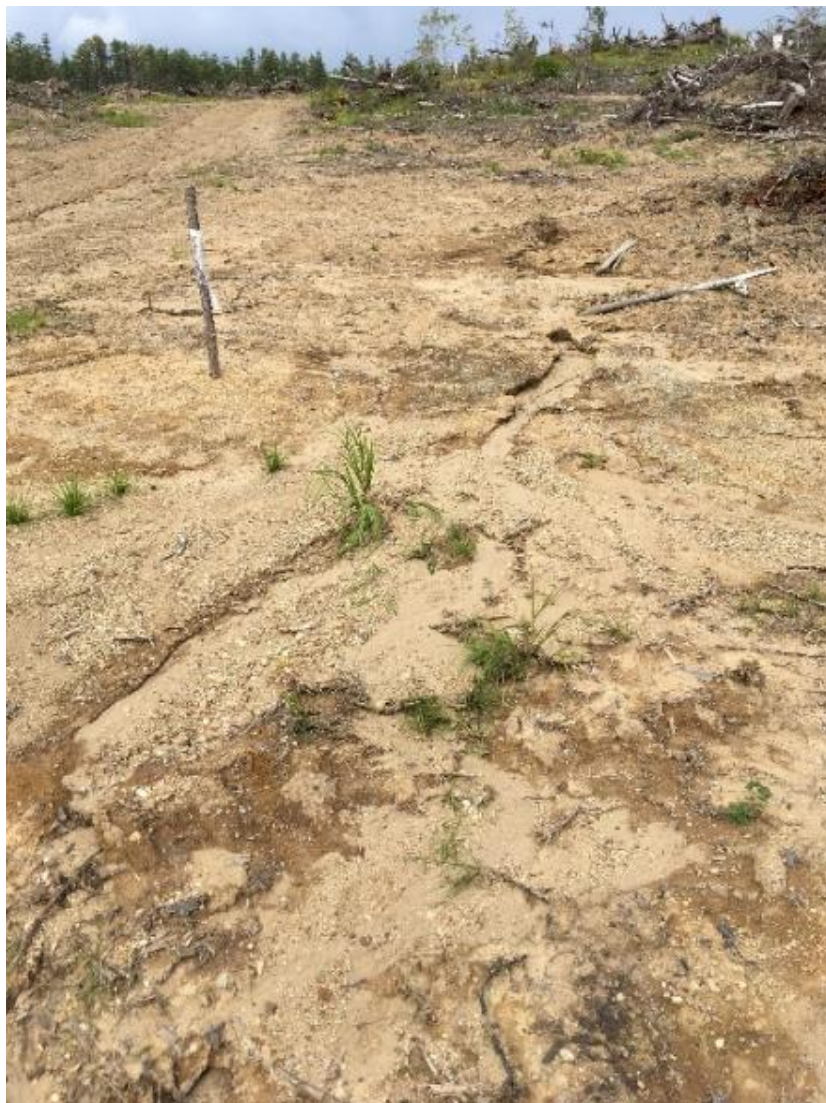
Фото 35. Эрозия почвы на предполагаемой площадке НКС-3.
