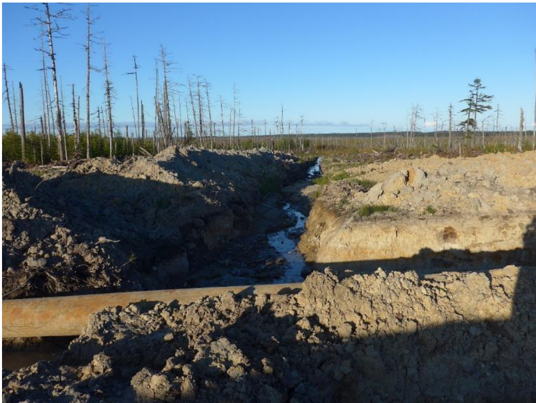
Фото 31. Канавы, ведущая к сточному колодцу ливневой воды на севере площадки ДКС ОБТК.
