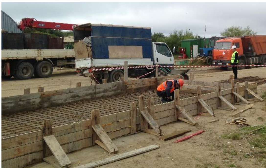
Фото 20. Строительство новых платформенных весов.
