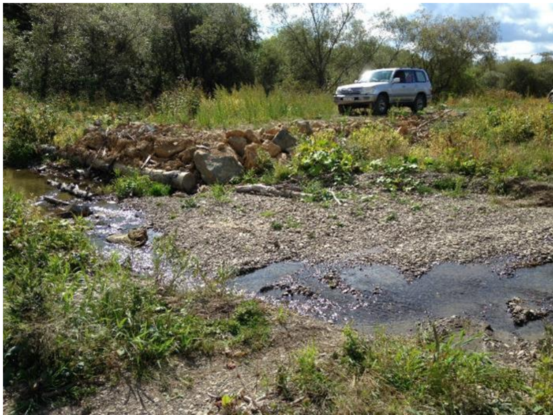
Фото 38. Небольшое водоток, пересекающий подъездную дорогу к НКС-4.
