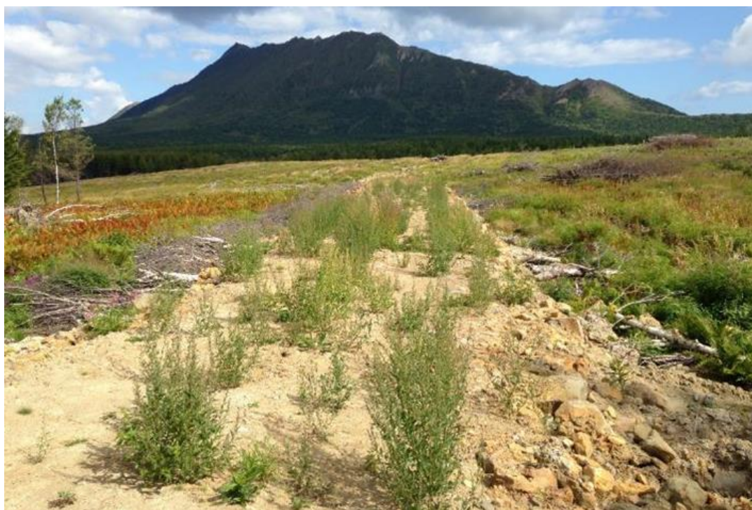
Фото 37. Часть расчищенной площадки для НКС-4.
