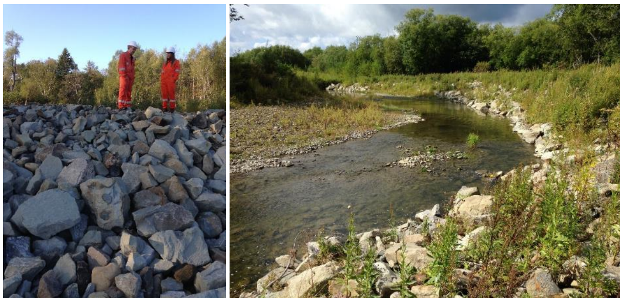
Фото 6. Недавно установленная каменная наброска без растительности (слева).
