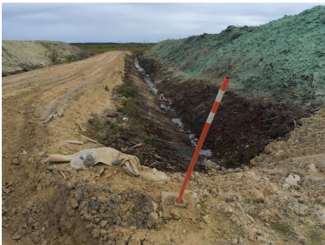
Фото 28. Торфяной вал и прилегающая дренажная канава.
