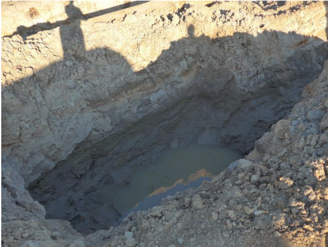
Фото 30. Сточный колодец для ливневой воды на севере площадки ДКС ОБТК.
