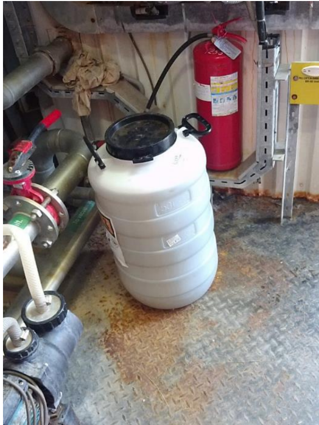
Фото 9. Бочка оксихлорида алюминия без поддона в УОСВ.
