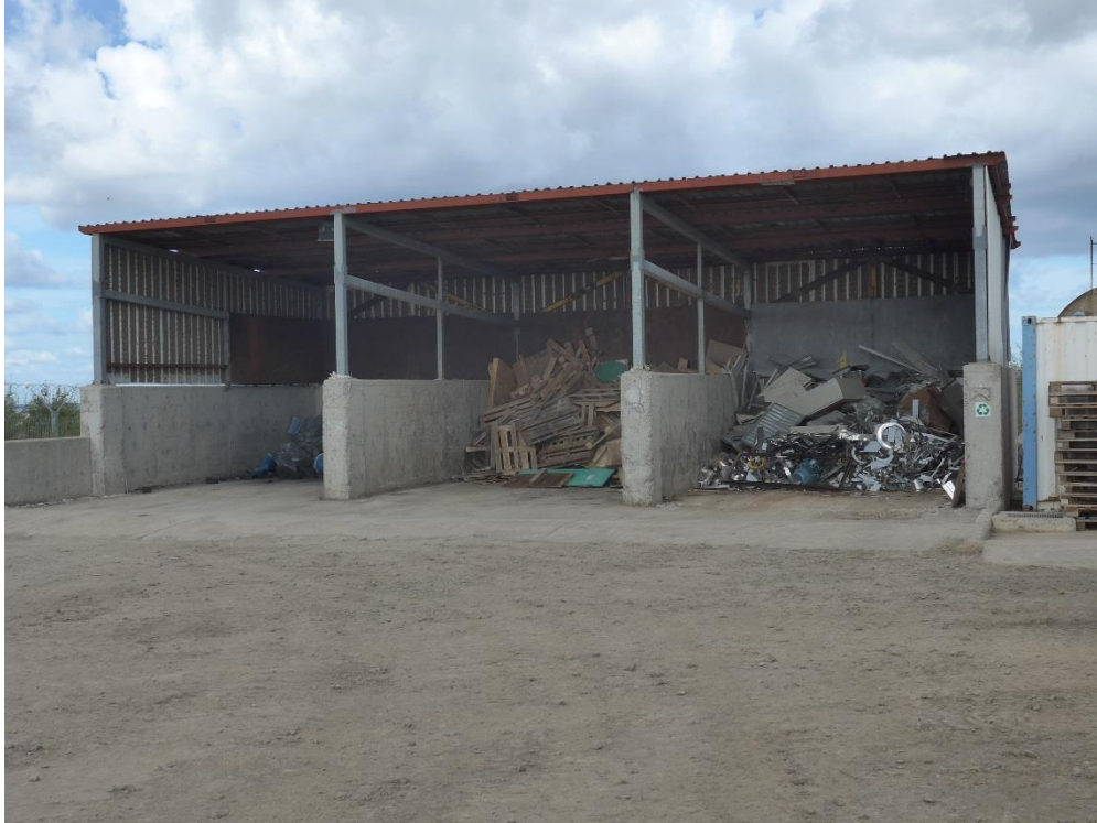
Фото 3. Зона хранения безопасных отходов на станции перегрузки.
