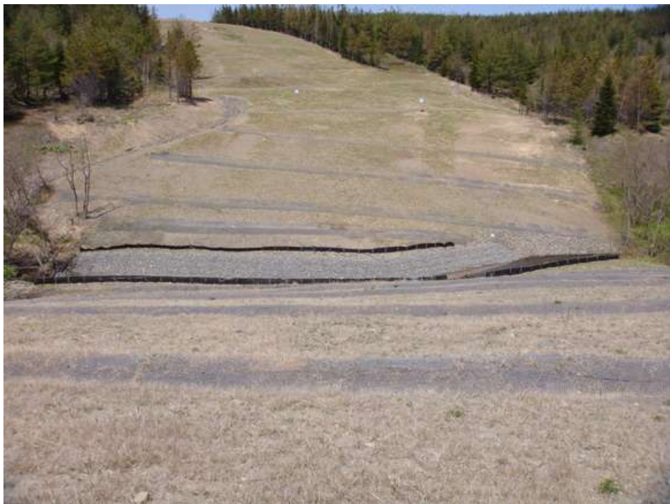
Фото 8. Переполнение рассекателя склона у реки Оркуньи.
