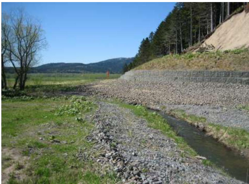
Фото 6. Боковая выемка с контрфорсом из многоступенчатой габионовой стены и земляным уплотнением. КП 304.
