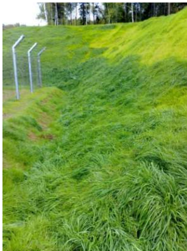
Фото 18. Буйный рост травы на узле крановых задвижек, 2008 год
