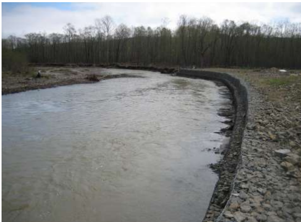
Фото 4. Габионы на берегах реки Лазовая на 2 переходе трубопровода. КП 384,5.
