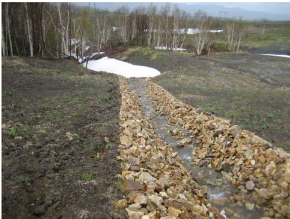
Фото 14. КП 434,9. Склон притока реки Травяная — применение каменной наброски для выстилки дренажного канала.
