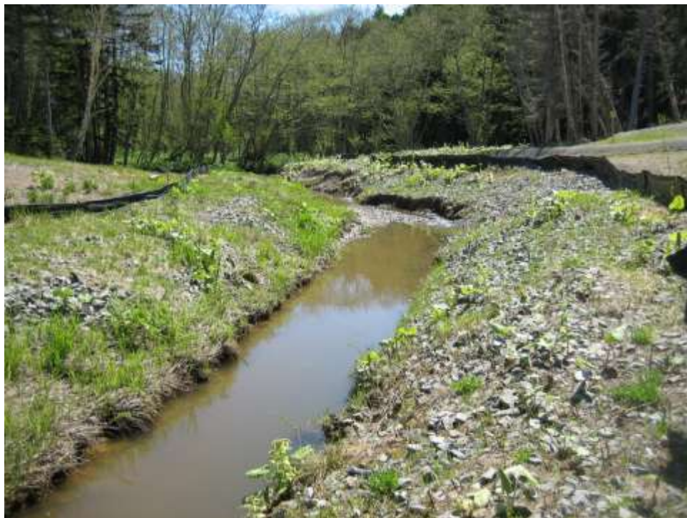
Фото 16. КП 15. Поврежденное противоиловое заграждение.
