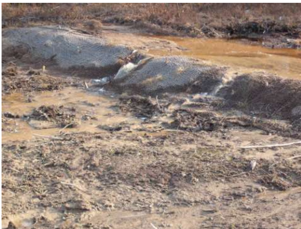
Фото 8. Переполнение рассекателя склона у реки Оркуньи.
