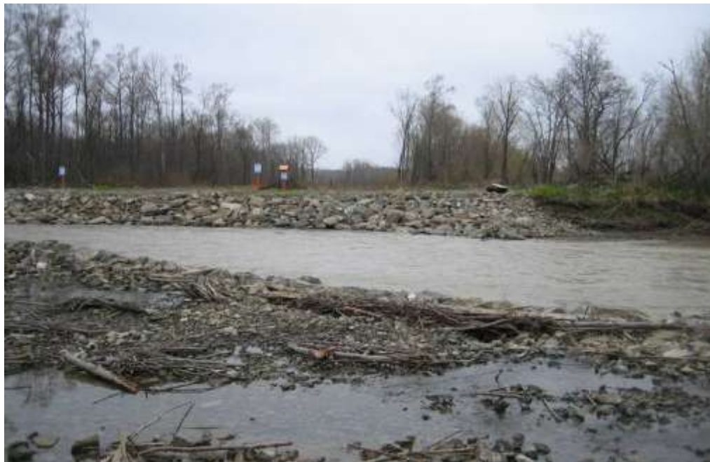
Фото 1. Река Нитуй. КП 326,6. Вид на обширные укрепления из каменной наброски на противоположном берегу.
