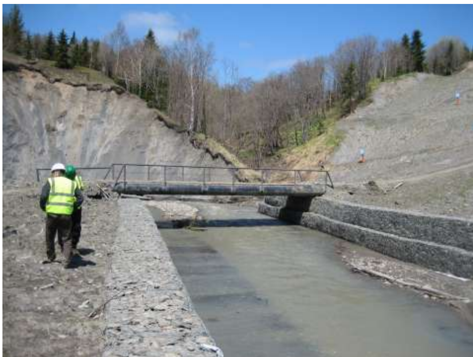
Фото 4. Габионы на берегах реки Лазовая на 2 переходе трубопровода. КП 384,5.
