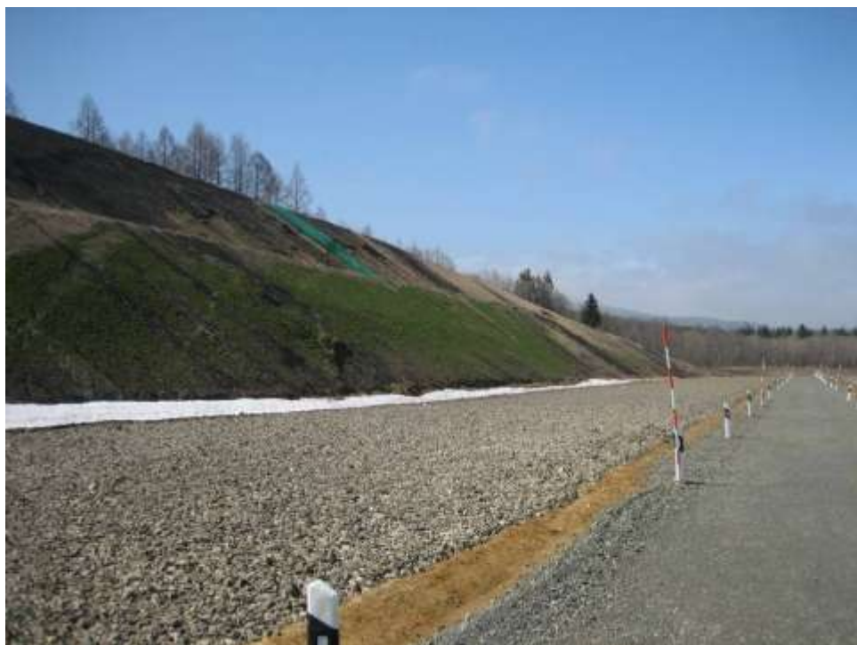
Фото 12. Частично успешное применение геотекстильных матов (Enkemat) для укрепления боковых выемок перехода через разлом земной коры. КП 304.
