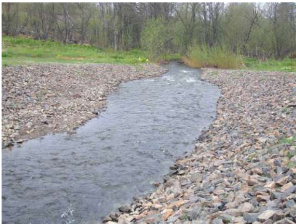
Фото 14. КП 434,9. Склон притока реки Травяная — применение каменной наброски для выстилки дренажного канала.
