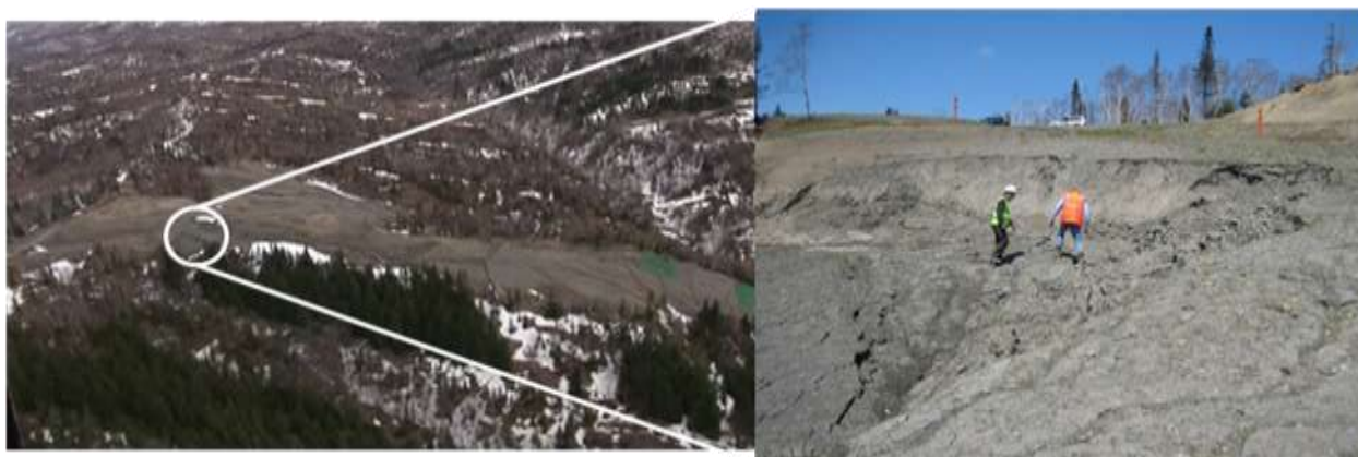
Фото 39. Видеокадр и фото участка обрушения склона на реке Седлец.
