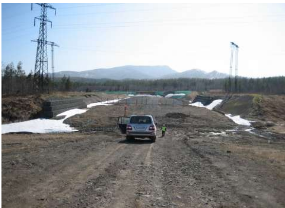
Фото 6. Боковая выемка с контрфорсом из многоступенчатой габионовой стены и земляным уплотнением. КП 304.
