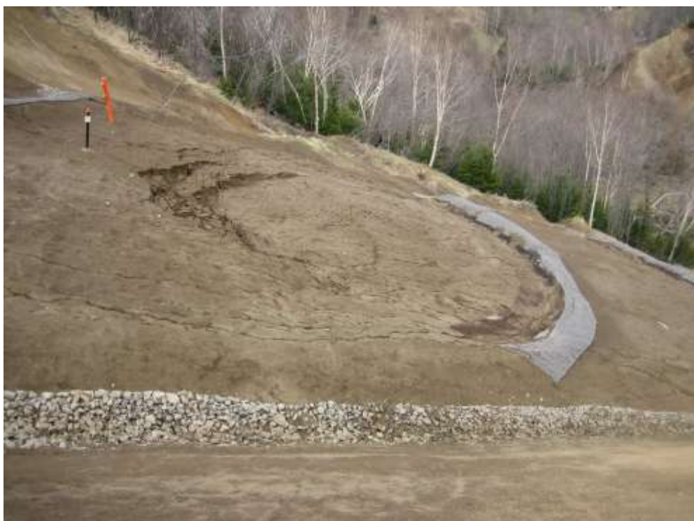
Фото 37. Начало обрушения южного склона реки Кормовая, КП 351.
