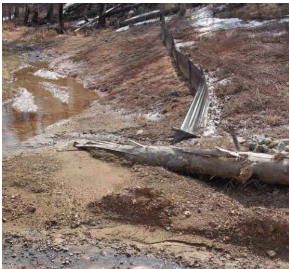
Фото 16. КП 15. Поврежденное противоиловое заграждение.
