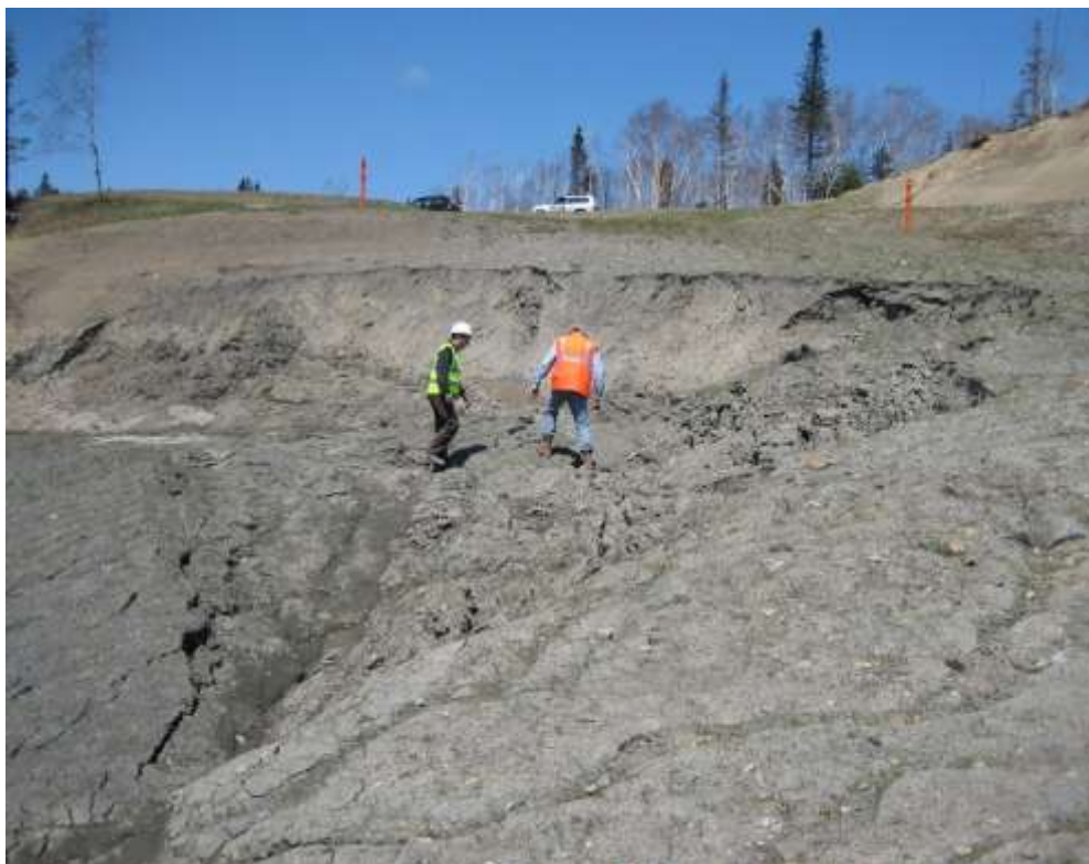
Фото 35. Обрушение северной части склона, ведущего к реке Седлец, КП 387.
