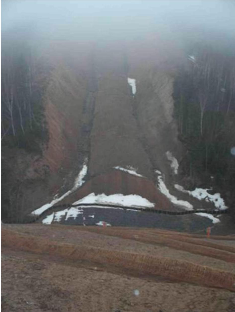
**Фото 14** КП 345 Гарь — Очень хорошая стабилизация крутого склона при помощи раскателей, бокового дренажа и геотекстиля на самых крутых участках. В обеих боковых дренажных канавах видны наносы, и небольшое количество наносов попадает в речное русло слева, что указывает на необходимость мониторинга и работ по содержанию участка.
