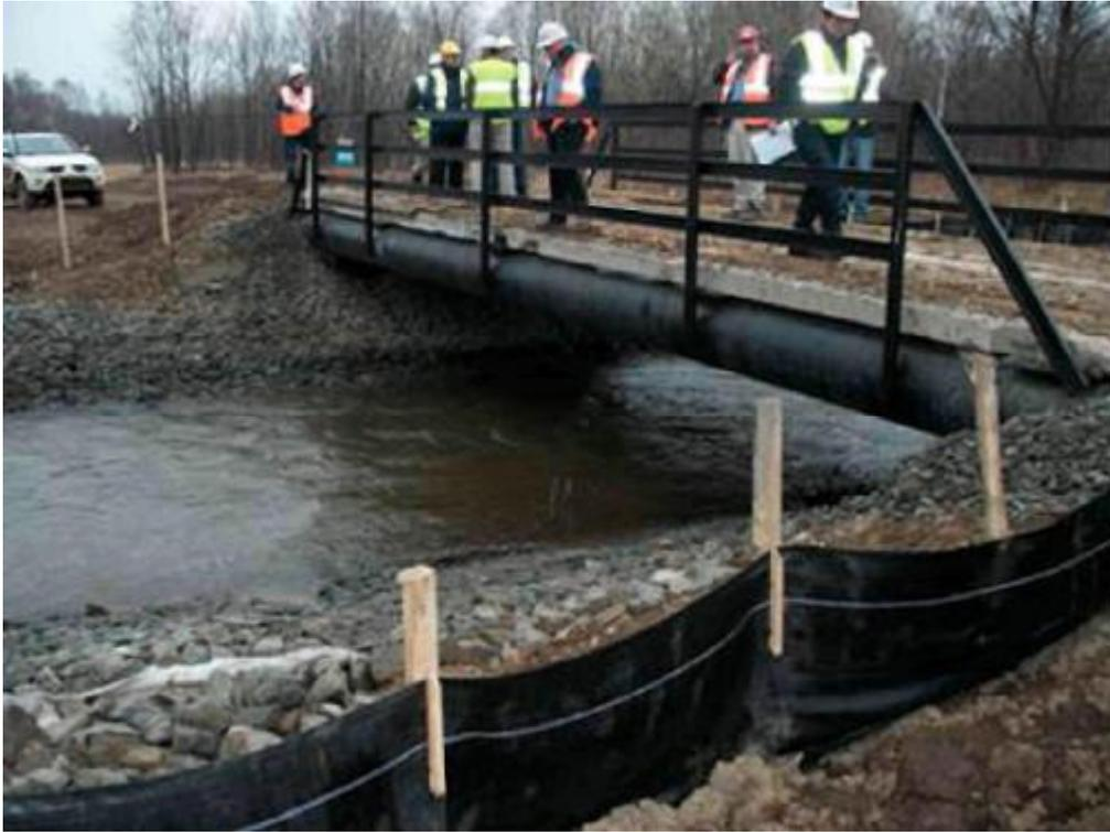
**Фото 15** КП 314 Мана — Новый постоянный мост. Следует установить противоилое заграждение, соединенное с конструкцией моста, пока недавно нарушенный грунт не стабилизируется. Аналогичные работы предстоит выполнить примерно на 60 мостовых переходах.
