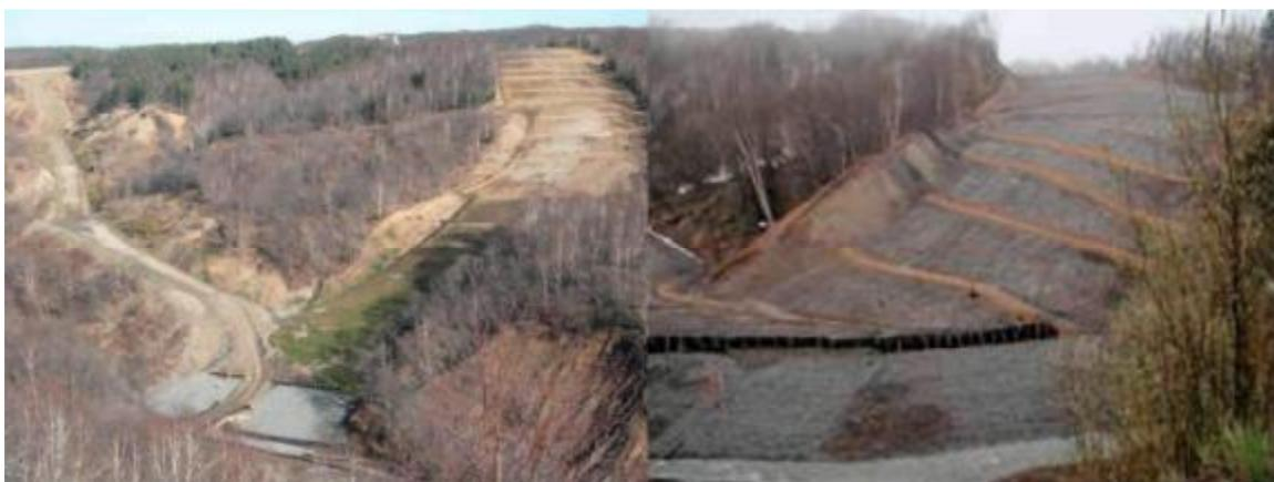
**Фото 19** Сравнение КП 348 Кринка в сентябре 2008 года и в мае 2009 года: наглядное проявление эффективности мер контроля эрозии после весеннего таяния снегов. Участок требует продолжения мониторинга.
