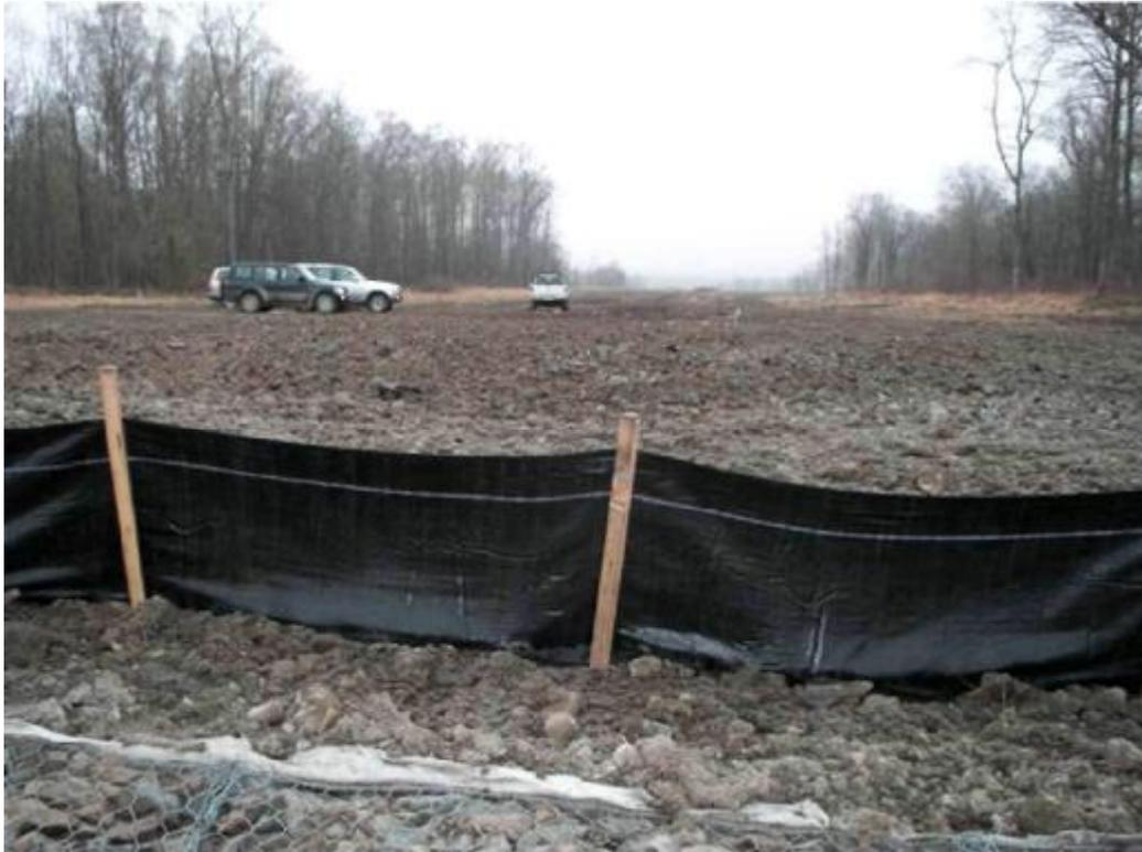
**Фото 22** Техническое восстановление (временная подъездная дорога все еще на месте) и биологическая рекультивация не закончены на КП 313 Горянка. По графику работы должны быть завершены летом 2009 года.
