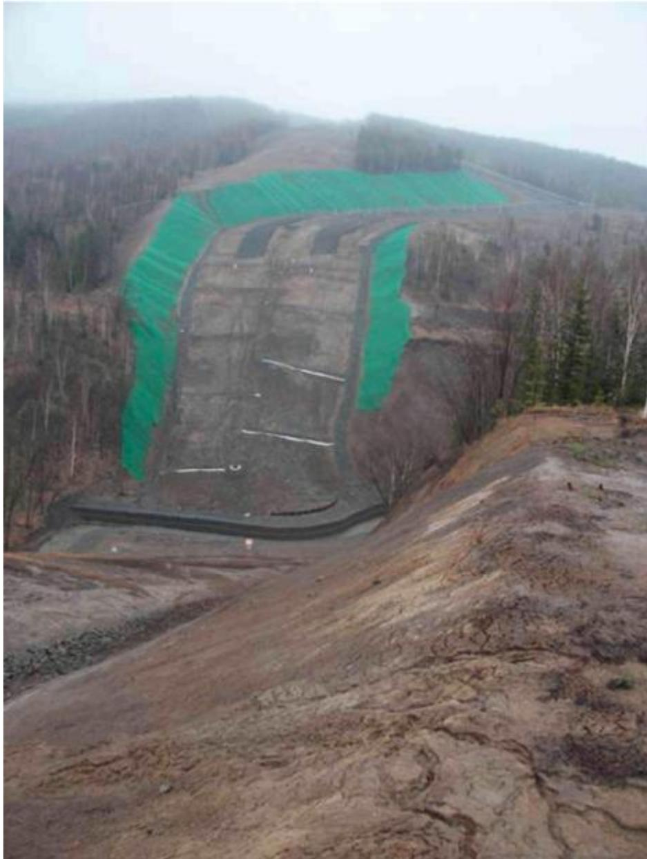
**Фото 13** КП 347 Кормовая— Эффективные раскатели склонов с матами, боковым дренажом с каменной наброской, боковыми выемками с геотекстилем. Небольшие промоины на незащищенной боковой выемке и заполнение дренажа наносами указывают на необходимость мониторинга и, возможно, работ по обслуживанию в будущем.
