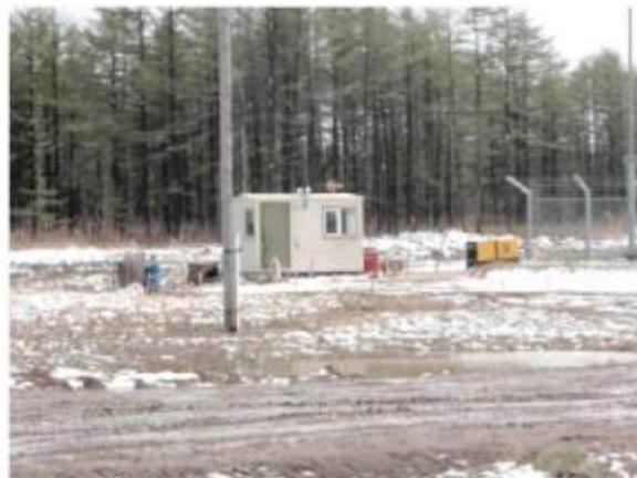
**Фото 23** Недостаточность средств вторичной локализации разливов (в разной степени) на разных УЗЕЛ КРАНОВЫХ ЗАДВИЖЕК. Эта проблема существует на всех участках трубопровода
