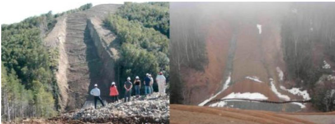
**Фото 17** Сравнение КП 345 Гарь в сентябре 2008 года и в мае 2009 года: видно, что реализованы дополнительные инженерные мероприятия (новые рассекатели склонов, боковые дренажные каналы с обеих сторон, геотекстиль на боковых выемках).
