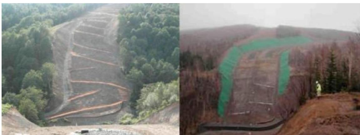
**Фото 18** Сравнение КП 347 Кормовая в сентябре 2008 года и в мае 2009 года: видно, что реализованы дополнительные инженерные мероприятия (новые рассекатели склонов, боковые дренажные каналы с обеих сторон, геотекстиль на боковых выемках).
