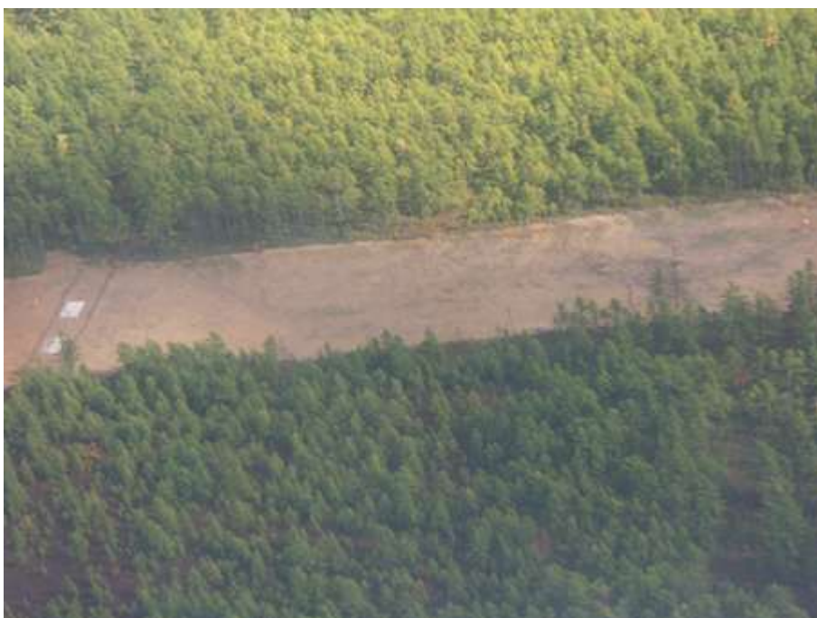
Фото 18 Бетонные плиты и высокие земляные насыпи слева на снимке защищают трубопроводы от автомобильного транспорта на общественной дороге и, соответственно, предохраняют полосу отвода от незаконного пользования.
