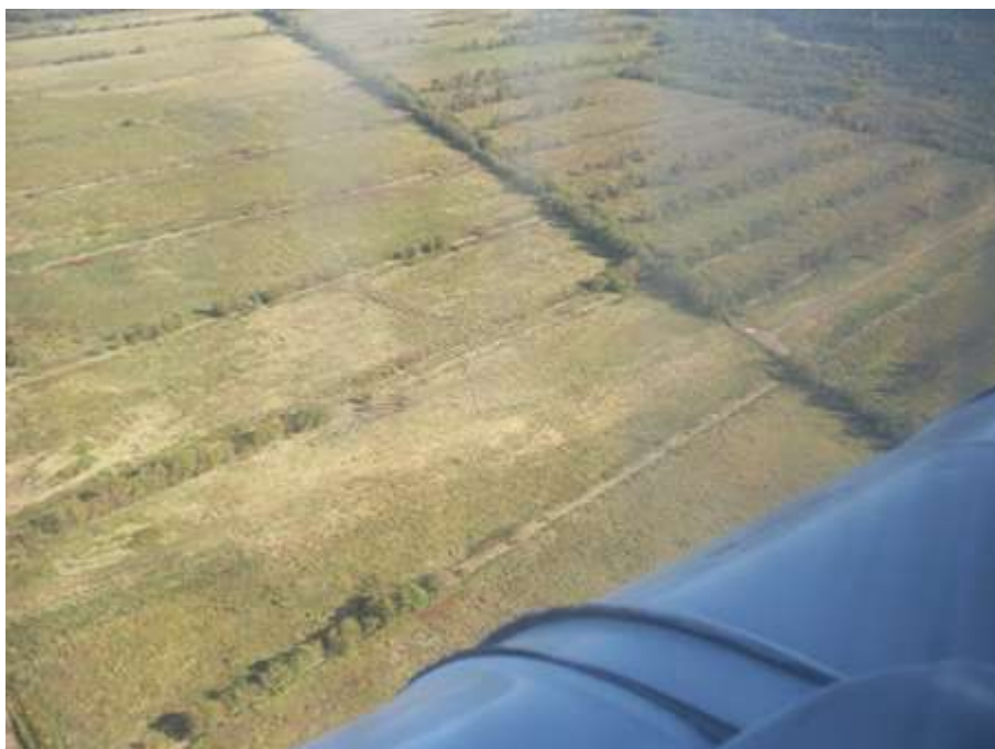
Фото 13 Полосу отвода трудно различить в окружении сельскохозяйственных земель. Проездная трасса и бетонные плиты на дороге общего пользования (справа) указывают на место полосы отвода.
