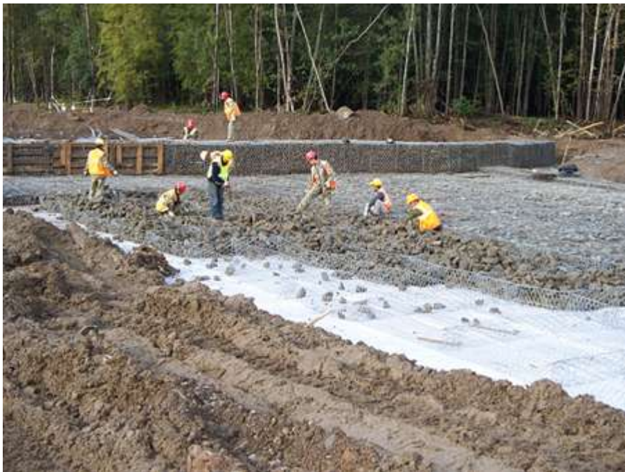
Фото 4 Установка новых защитных сооружений на реке Горная. Габионы и матрасы Рено предотвратят будущие повреждения в случае подобных событий.
