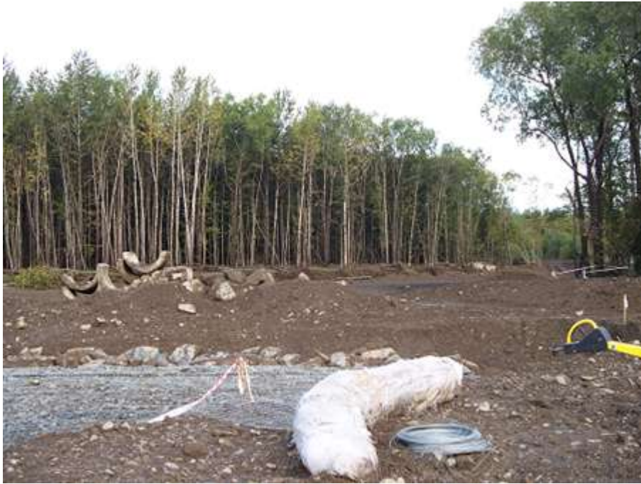
Фото 3 Повреждения на переходе через реку Горная, вызванные тайфуном. Отметьте боковую выемку грунта размером 1 м вдали и массы бетона, вытесненные ливневыми стоками.
