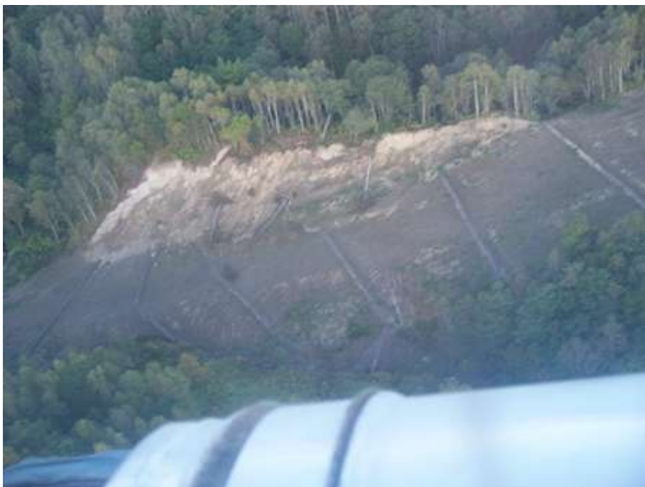
Фото 8 Эрозия на открытой боковой выемке грунта. Обратите внимания на поваленные деревья. На данный момент угрозы отсутствуют, но в будущем защитные мероприятия необходимы.
