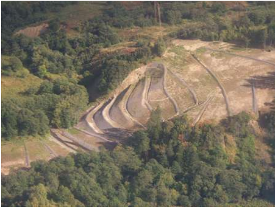
Фото 5 Типичная картина рекультивации полосы отвода. Матрасы Рено обеспечивают надлежащую защиту: рассекатели и дренажные конструкции на склоне не повреждены.
