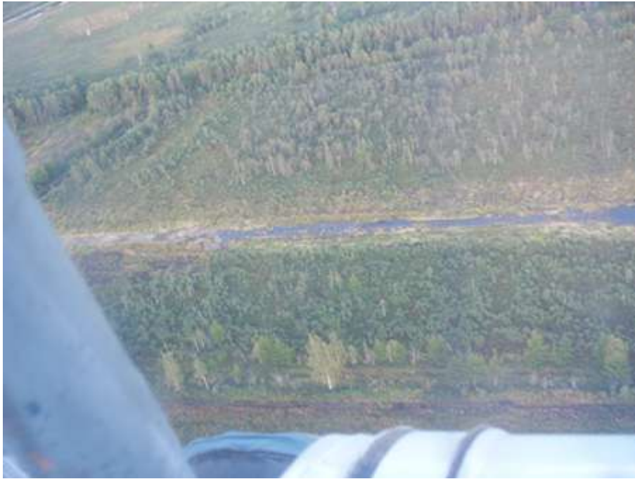
Фото 15 Просадки грунта вдоль полосы отвода приводят к слиянию вод, особенно в водно-болотных угодьях. На данный момент угрозы отсутствуют, но в будущем необходим контроль.
