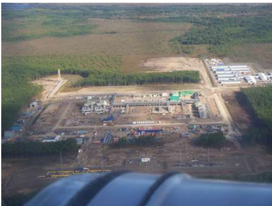
Фото 20 Насосно-компрессорная станция № 2 близка к завершению, готова к вводу в эксплуатацию через несколько дней и к выводу на проектную мощность не позднее чем через два месяца.
