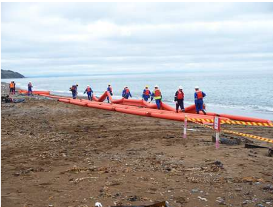
Фото 28 Для установки боновых заграждений вручную требуется много времени.
