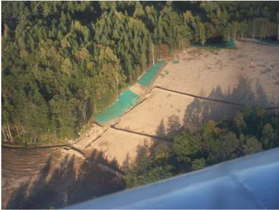
Фото 9 Повреждение рассекателей склонов, приводящее к эрозии и образованию канав. На данный момент угрозы отсутствуют, но в будущем защитные мероприятия необходимы.
