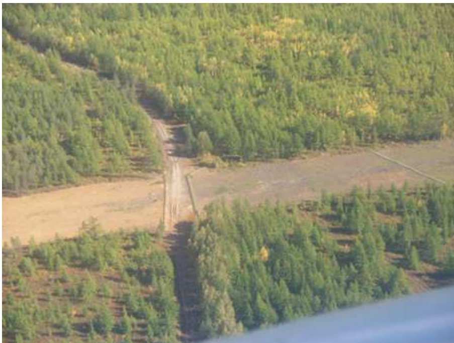
Фото 19 Крупные земляные насыпи препятствуют легкому доступу местных жителей в полосу отвода с дорог общего пользования, которые остаются открытыми.
