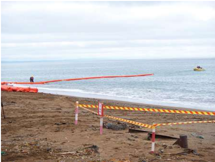
Фото 29 Установка боновых заграждений с помощью недостаточно мощной надувной лодки также выполняется медленнее, чем хотелось бы.
