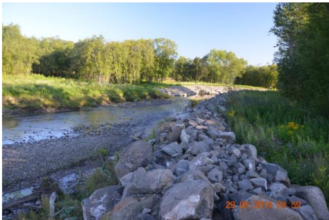
Фото 3.20. Наземный фотоснимок реки Нитуй и новой каменной наброски
