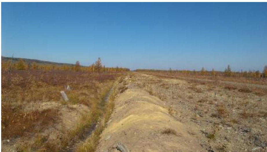
Фото 3.11. Траншея и берма возле КП 231, не пропускающие воду к ПЗ и к болоту с восточной стороны ПЗ.
