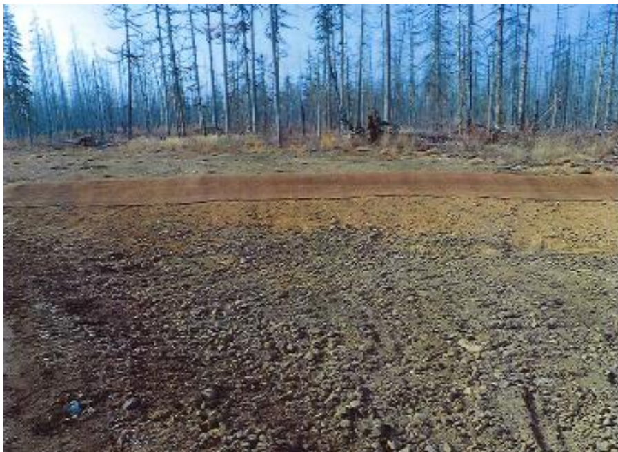
Фото 3.15. ПЗ в районе КП 15 21 октября 2013 г. после ремонта и восстановления
