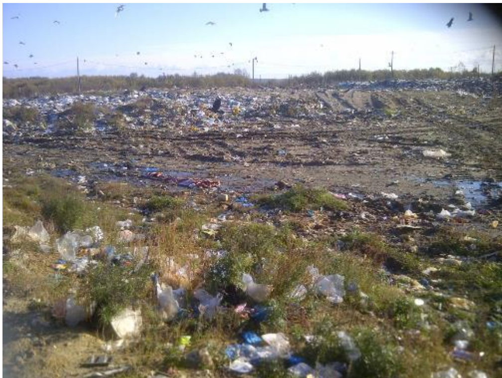
Фото 5.1. Отсутствие ежедневной засыпки на полигоне Ноглики
