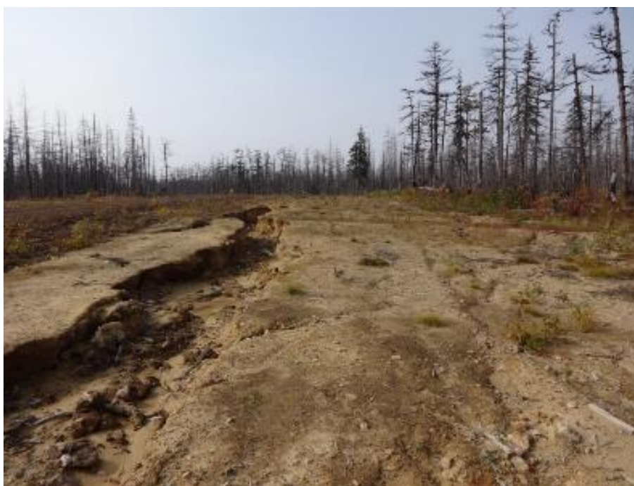
Фото 3.14. ПЗ в районе КП 15 в сентябре 2013 г. с признаками развивающейся эрозии
