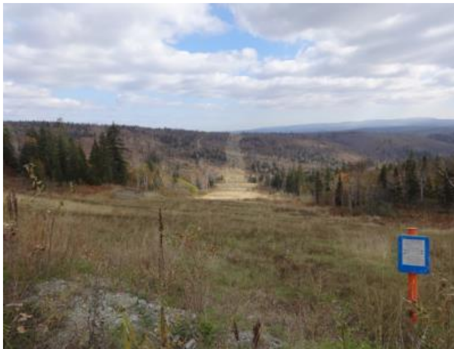
Фото 3.16. Склоны с хорошо сформировавшейся растительностью на геоджутовых матах в районе КП 47
