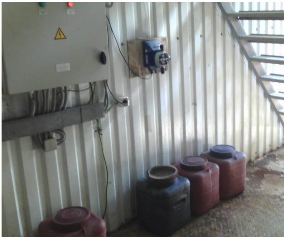
Фото 4.1. Немаркированные емкости без средств вторичной локализации на установке BR-200
