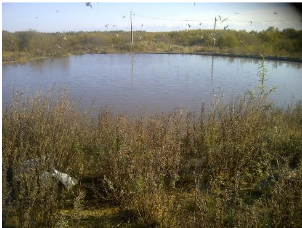
Фото 5.2. Переполненный пруд очистки фильтрата на полигоне Ноглики
