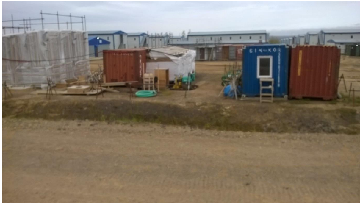
Фотография 10. Оборудование хранится с поддонами под ним
