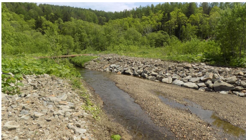
Фотография 1. Русло реки Дуэт с каменной наброской для укрепления берегов по обе стороны речного перехода.
