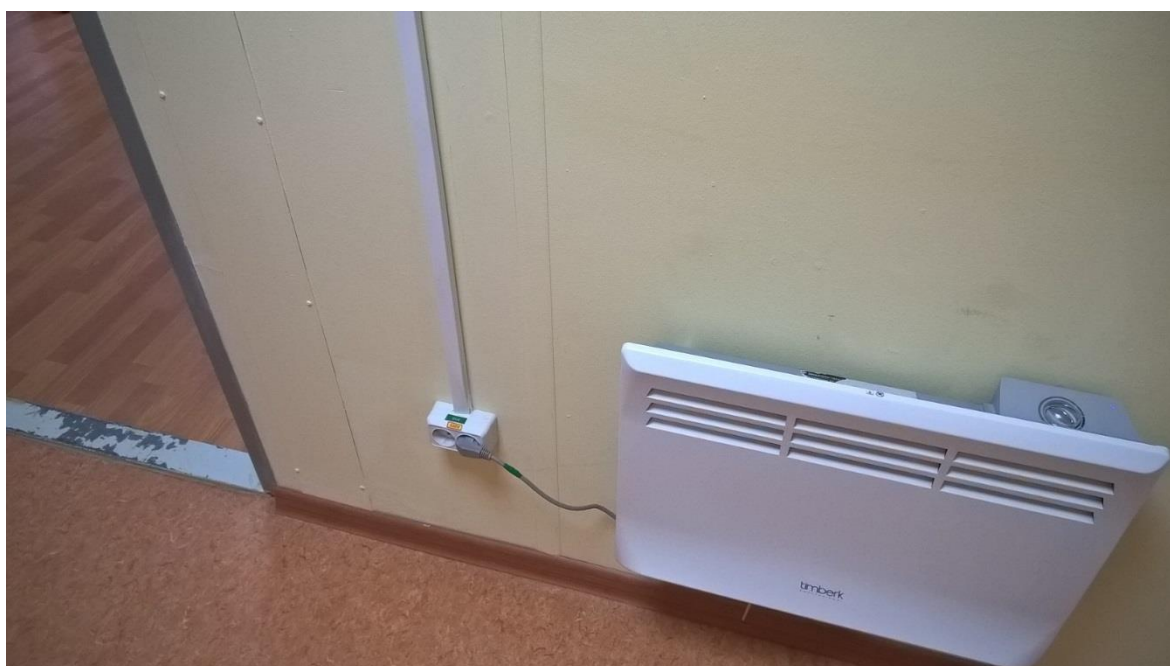
Фотография 5. Новая система отопления в жилом здании. Обратите внимание на цветовую маркировку электрического устройства, показывающую, что оборудование проверено и исправно
