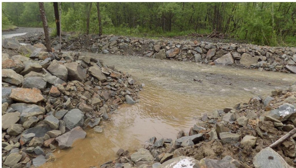
Фотография 1. Восстановленные и укрепленные берега реки Середка и обводный канал.
