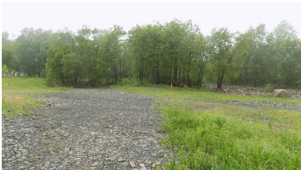
Фотография 2. Восстановленное русло, вымытое меандрирующей рекой в месте вскрытия трубопровода. Восстановленное русло реки видно в правой части фотографии.
