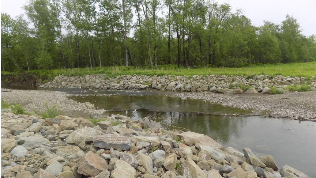
Фотография 2. Переход через реку Нитуй в превосходном состоянии и без каких-либо признаков повреждений.
