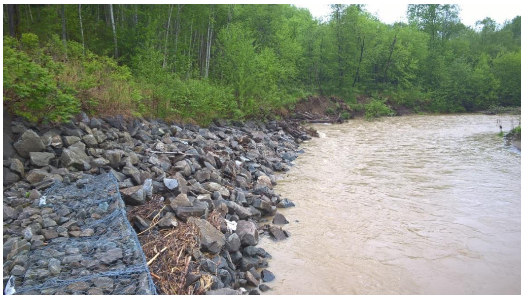
Фотография 1. На западе открывается вид на хорошее состояние берегозащитных сооружений, но дальше вдоль берега происходит разрушение.
