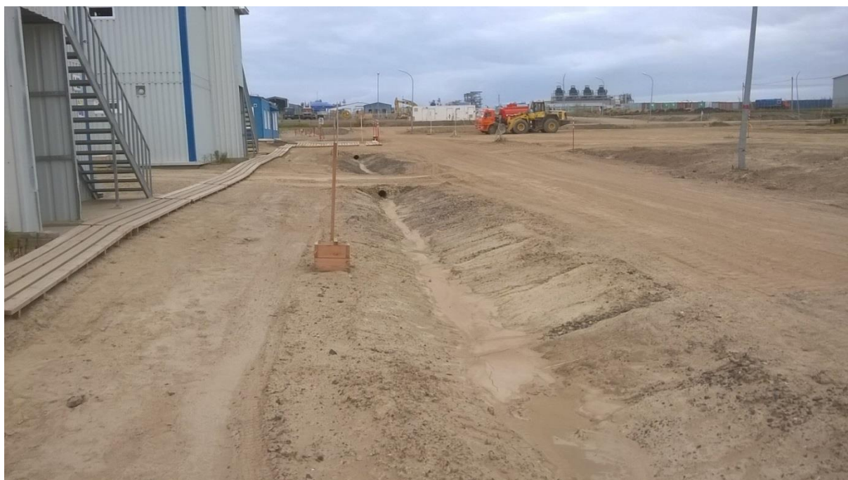
Фотография 6. Дренажная канава во временном поселке с новыми водопропускными трубами
