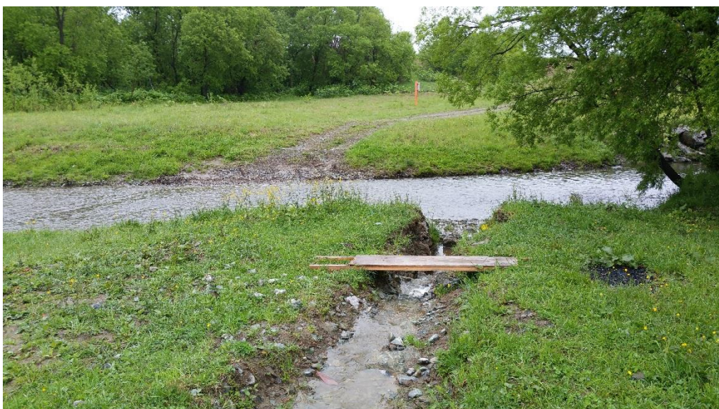
Фотография 3. Дренажная канава, обустроенная сторонними лицами.
