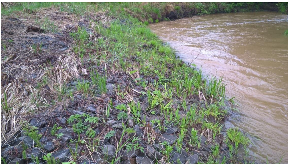
Фотография 3. Габбионы с каменным заполнением вдоль реки покрываются растительностью.
