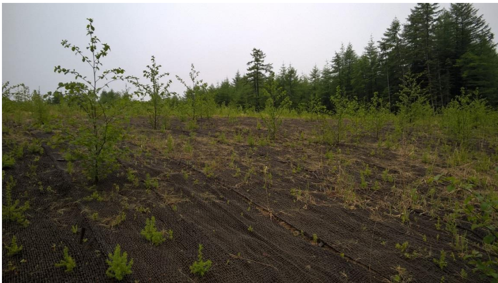
Фотография 2. Крупный план геоматов, которые остаются на месте и (медленно) зарастают травой, предотвращая эрозию.
