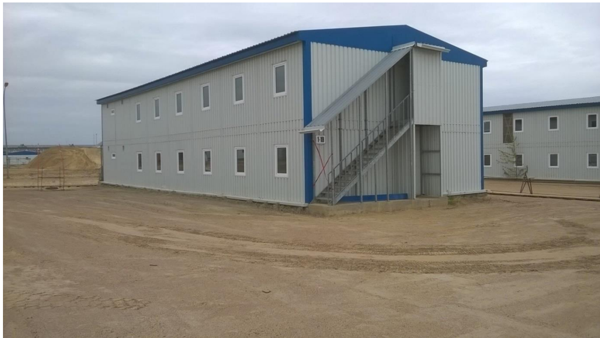
Фотография 2. Переоборудование здания не ведется в связи с его текущим состоянием – обратите внимание на красную ленту, перекрывающую вход
