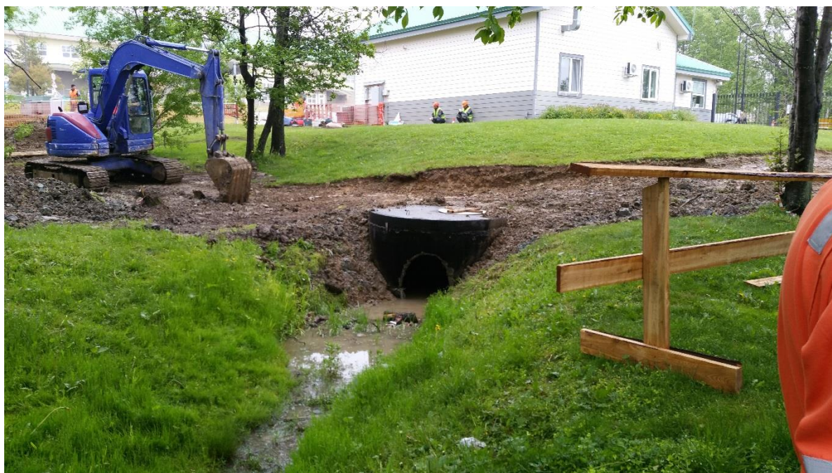
Фотография 21. Строительные работы по переносу точки сброса стоков УОСВ комплекса «Зима» в ручей Правый, которые привели к стоку наносов.
