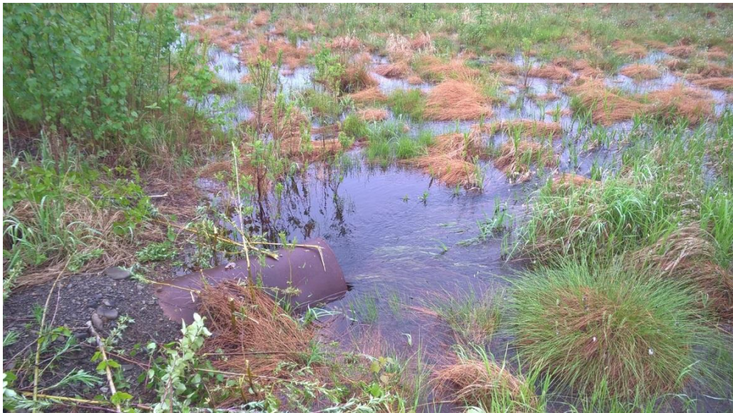
Фотография 3. Значительное скопление воды на западной стороне подъездного пути стекает через водопропускную трубу.
