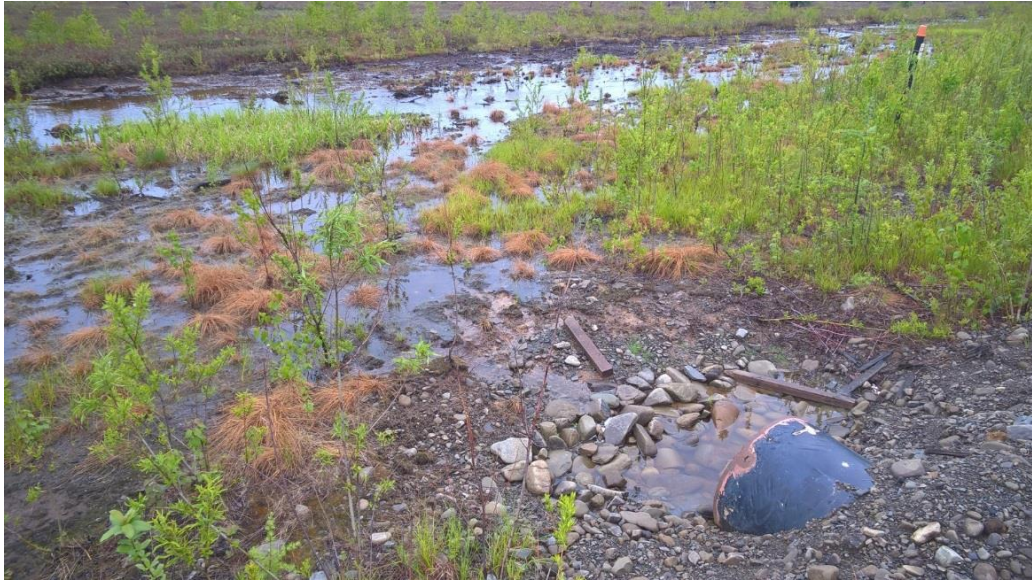
Фотография 2. Новая водопропускная труба хорошо пропускает воду через подъездной путь с запада на восток.
