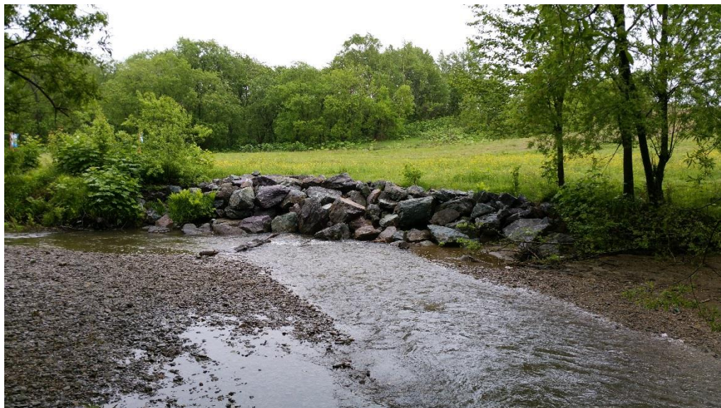
Фотография 1. Каменная наброска на разрушающийся берег.
