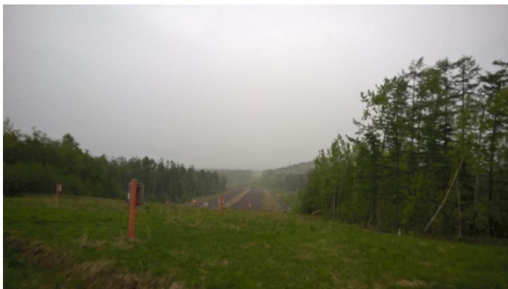
Фотография 1. Вид на переход через разлом № 3.
