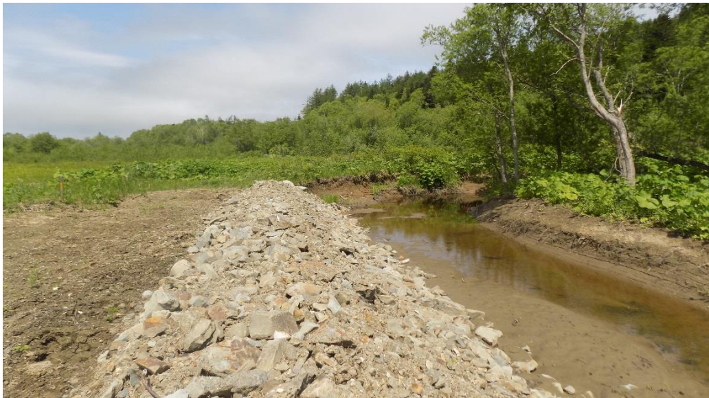
Фотография 3. Каменная наброска и восстановление разрушенного берега.
