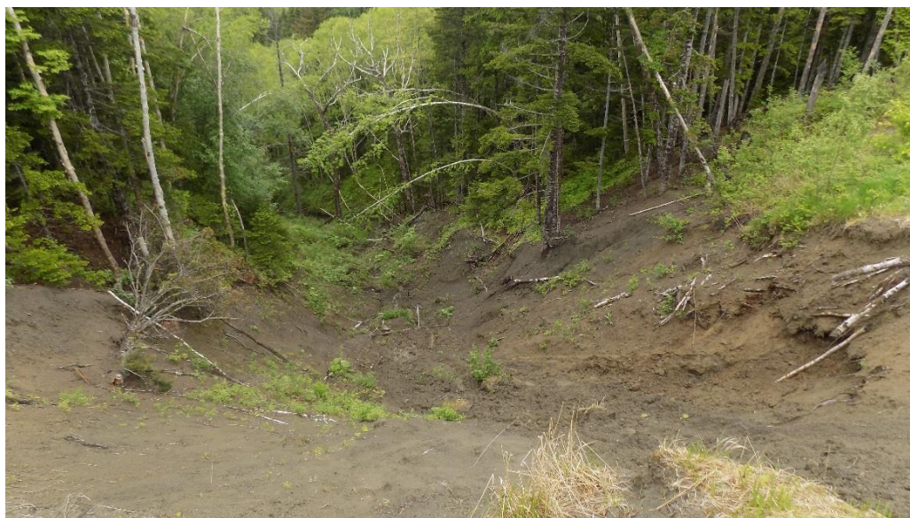
Фотография 1. Крупный оползень между КП 380 и 381. Продолжается детальное проектирование и планирование для завершения восстановительных работ.
