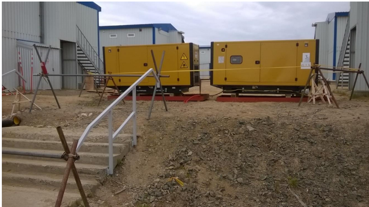
Фотография 8. Генераторы с поддонами под ними
