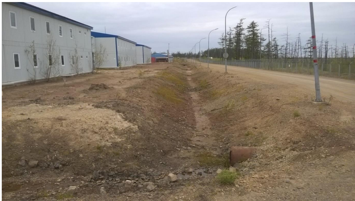
Фотография 7. Северо-восточный угол площадки, где дренажные канавы сходятся к выпускной трубе, отводящей воду за пределы площадки
