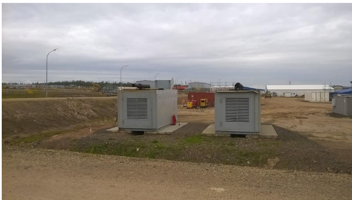
Фотография 9. Главные генераторы поселка, для которых предусмотрены меры по локализации разлива и предотвращения загрязнения грунта
