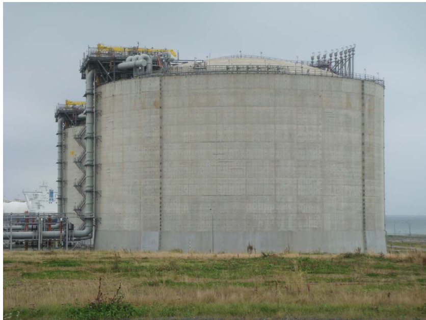
Photo 8: LNG storage tank
