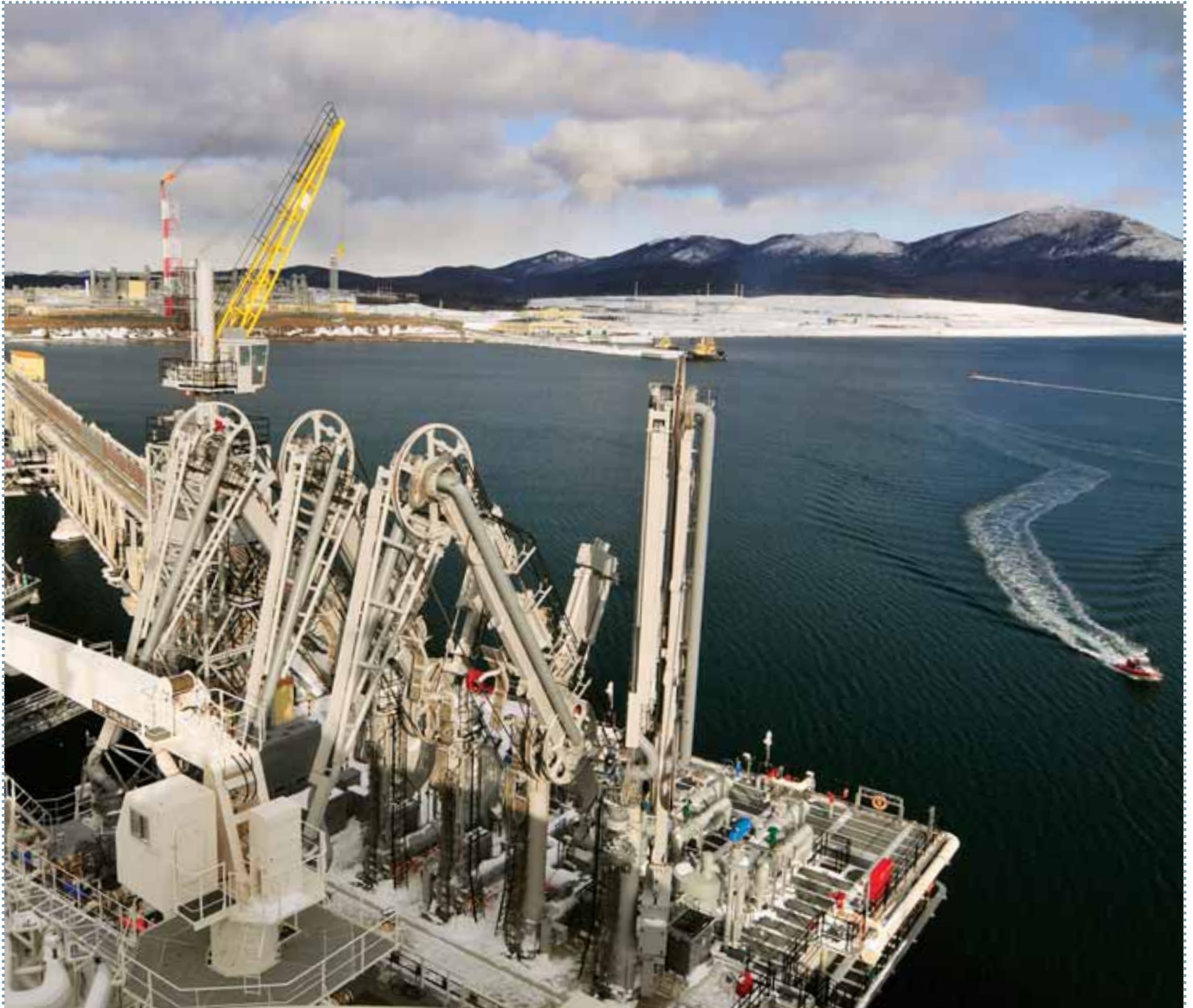
LNG jetty, Prigorodnoye production complex
