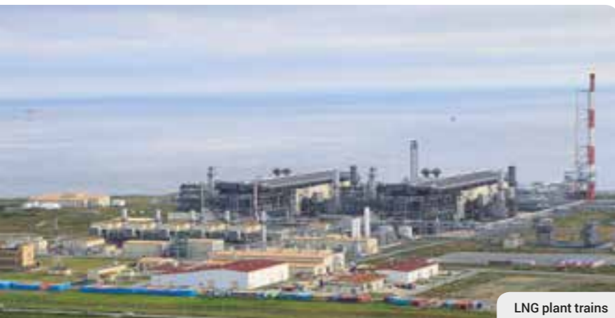
LNG plant trains
