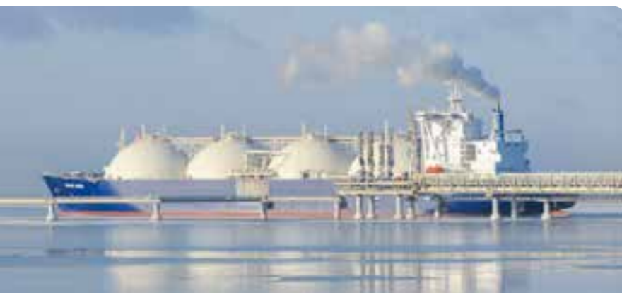
LNG tanker moored to the jetty
