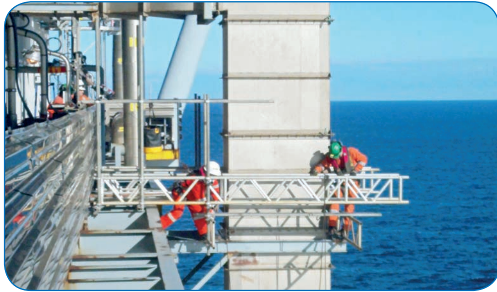
Строительство лесов для ремонта вентиляционного короба на платформе ПА-Б
