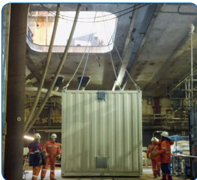
Погрузка контейнера в ядро платформы
