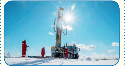
Буровые работы на месте строительства Сахалинского индустриального парка
