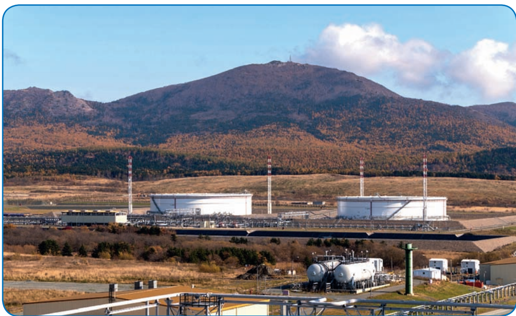
Резервуары хранения нефти производственного комплекса «Пригородное»
