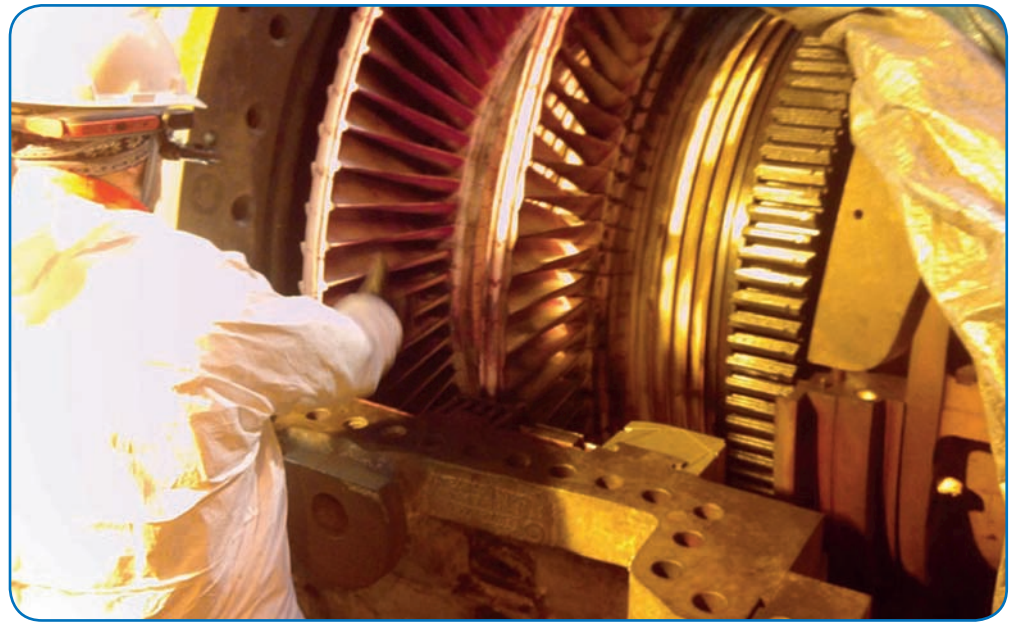
Шлемы удаленной поддержки позволяют проводить ремонт с онлайн-подключением инженеров из разных точек мира
