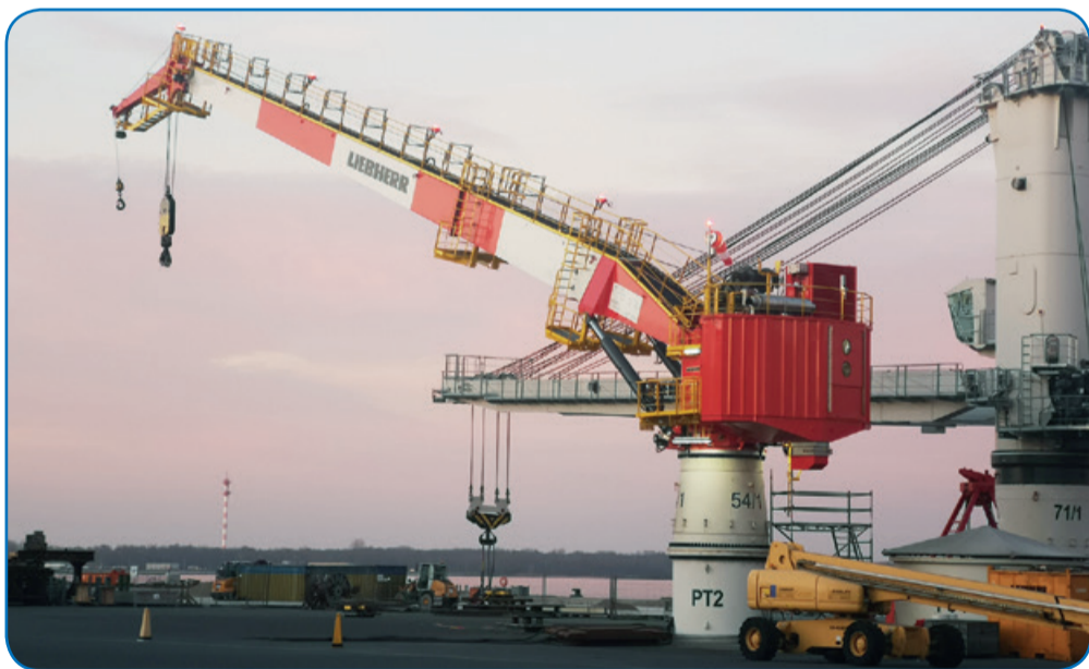
Заводские испытания нового крана
