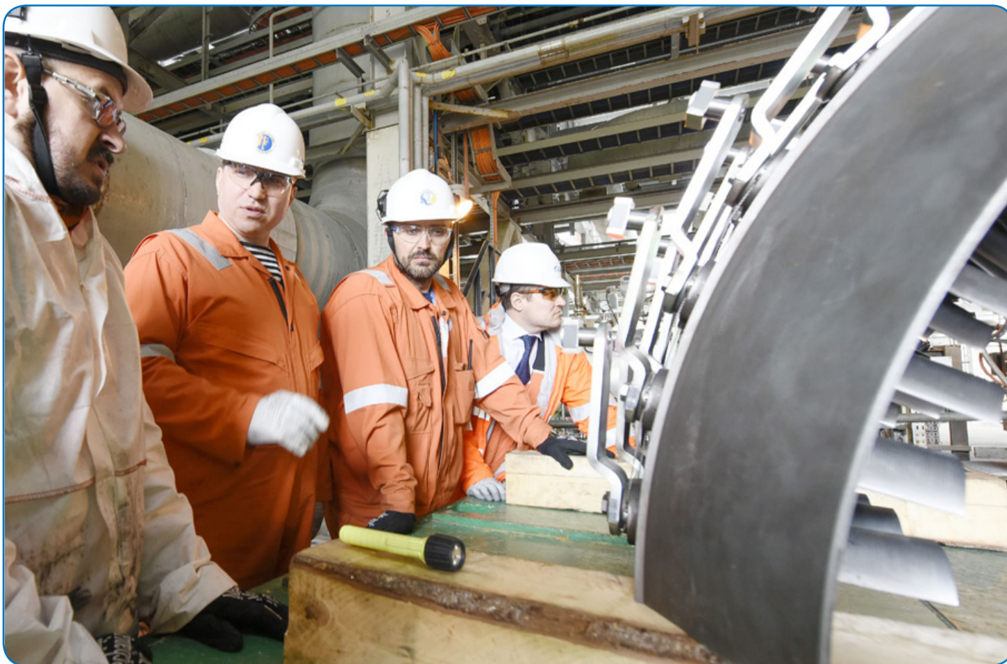
Замена оборудования во время планового технологического останова на заводе по производству СПГ
