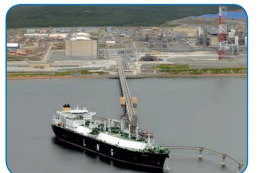
5 июня 2007 года. Танкер Granosa у причала отгрузки СПГ строящегося завода. Судно доставило первую из двух партий, предназначенных для начала проверки систем завода СПГ и проведения на нем пусконаладочных работ. СПГ был регазифицирован и запущен в систему для поэтапного охлаждения и введения в действие различных агрегатов. Использование импортного газа позволило быстрее ввести завод в эксплуатацию, так как пусконаладочные работы велись одновременно с завершающей стадией строительных работ
