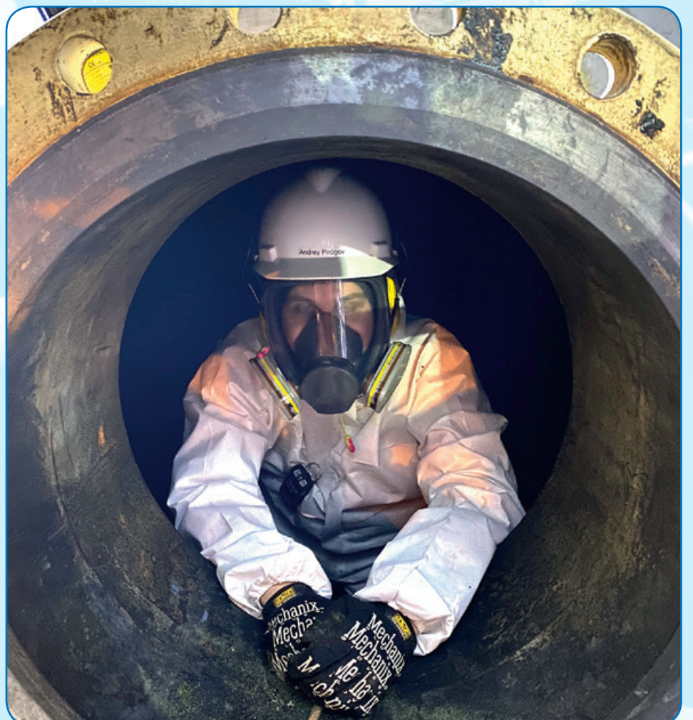
Работы в замкнутом пространстве
