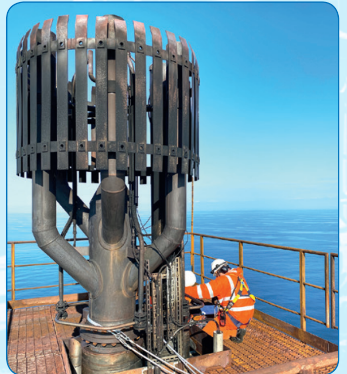
Электроработы в зоне факельного оголовка
