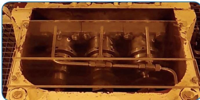
Рис. 3. Было: дренажные трубки мешают подтягивать уплотнения
