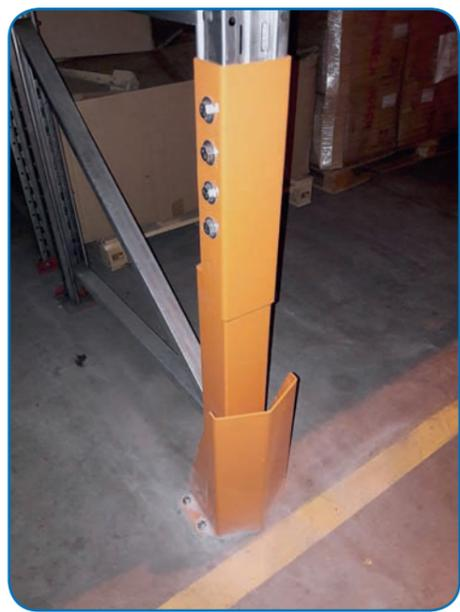
«Робусто» не только снимает нагрузку с поврежденного элемента, но и увеличивает жесткость и устойчивость самой стойки
