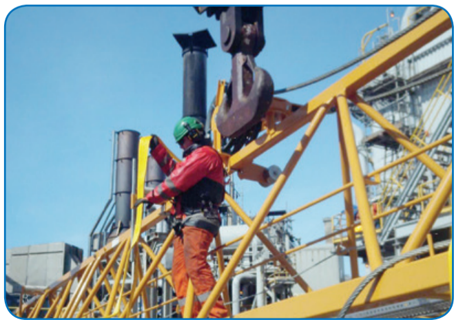
Процесс установки стрелы временного строительного крана
