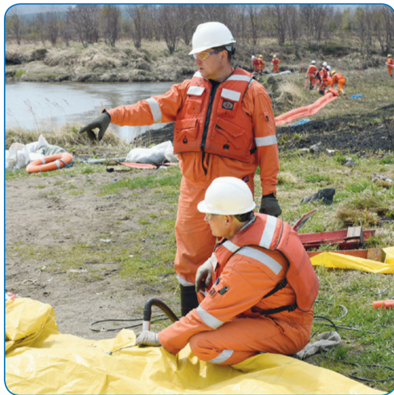
Подготовка боновых заграждений к установке
