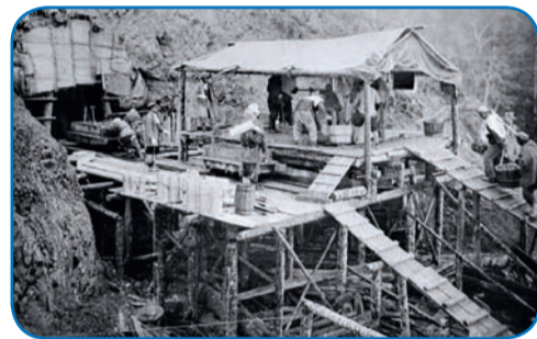
Строительство железной дороги Южно-Сахалинск – Холмск
