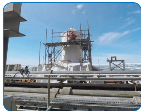
Возведение строительных лесов для установки крана
