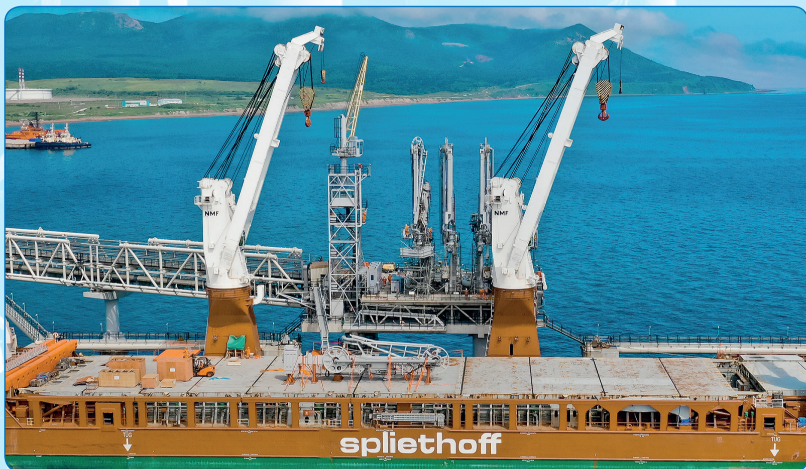
Replacement of two loading arms at LNG jetty
