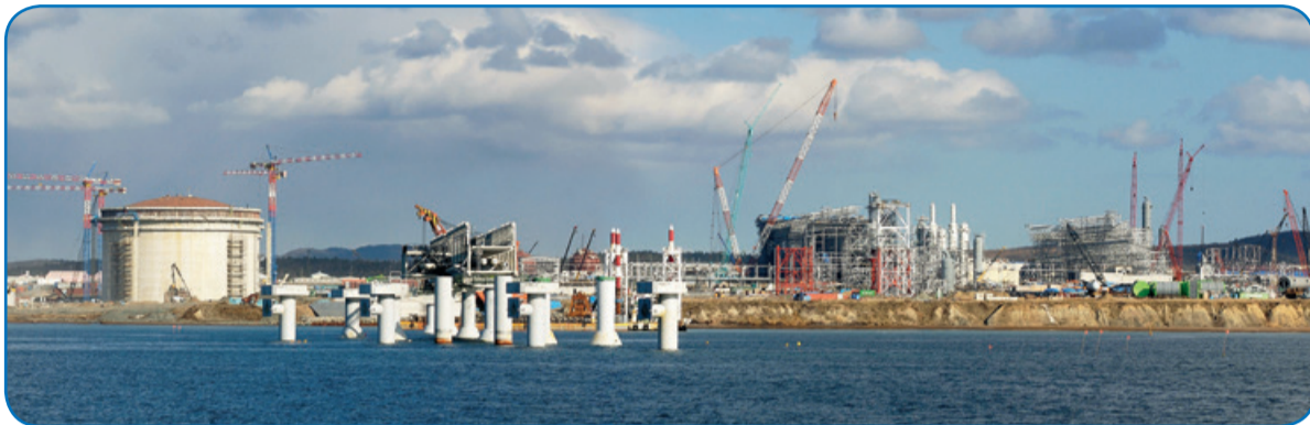
Строительство причала для отгрузки СПГ
