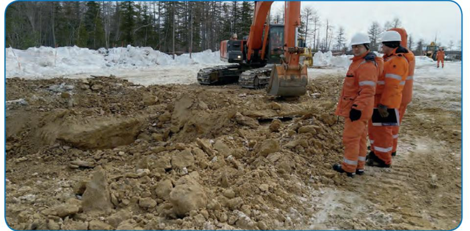
Согласно сценарию учений на 123-м километре трассы экскаватор повредил магистральный газопровод, в результате чего образовался «свищ». После падения давления в газопроводе были закрыты линейные краны и прекращена транспортировка газа. Следует отметить, что повреждения трубопровода такого масштаба крайне маловероятны, поэтому и отработка определенных действий и навыков, необходимых для ликвидации подобной утечки, ранее не проводилась
