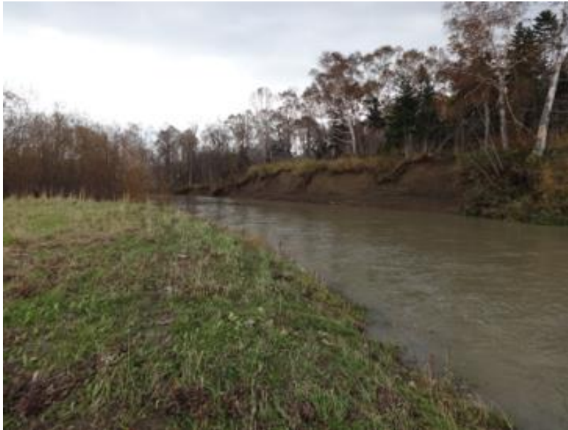
Фото 2. Вид на восточный берег ниже по течению.
