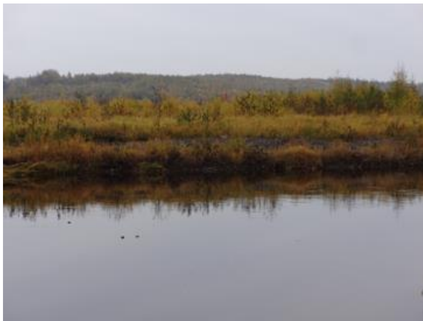
Фото 1. Вид через реку: видны берега, защищенные матрацами Рено.
