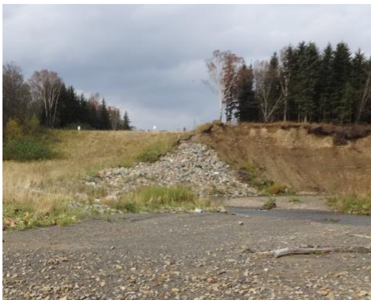
Фото 1. Вид на восстановленный участок берега и насыпи.
