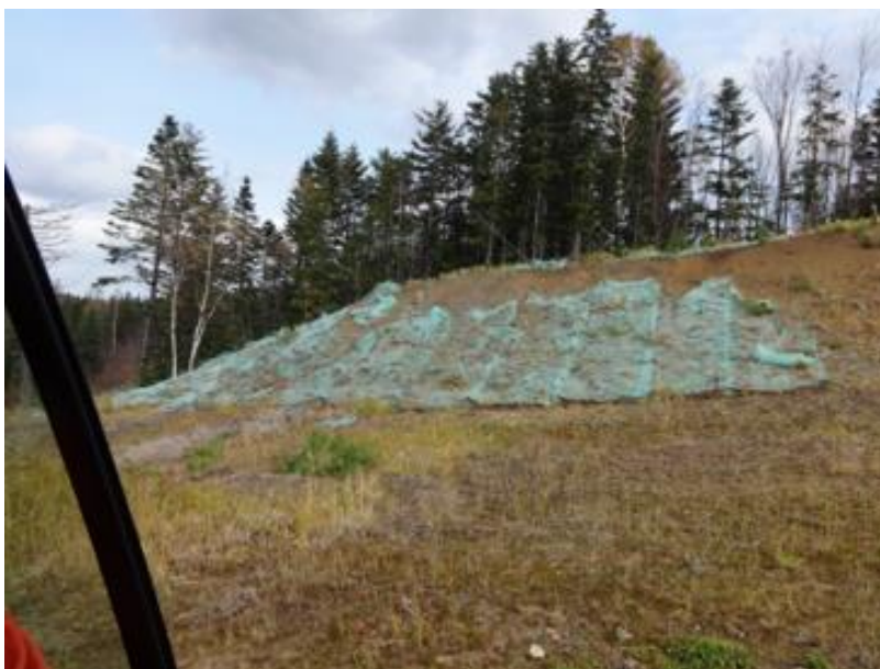
Фото 3. Вид на сторону ПО, на которой срублены деревья: на склоне виден сползающий геоджутовый мат.
