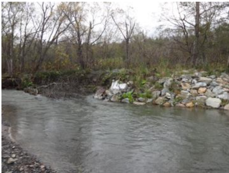
Фото 2. Вид на северный берег в месте, в котором поток врезается в насыпь за каменной наброской.
