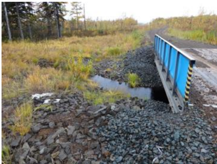
Фото 4. Вид на дренажный канал, защищенный каменной наброской и хорошо развитым растительным покровом.
