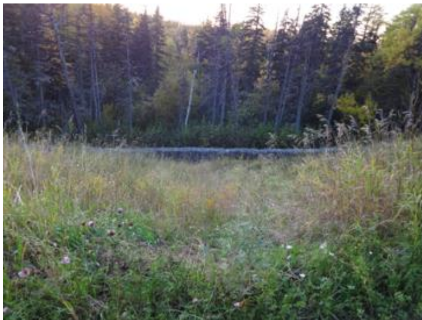
Фото 3. Вид на боковую сторону ПО: видна габионовая стенка для стабилизации склона.
