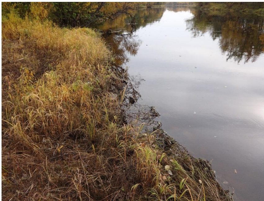
Фото 5. Вид на близкий северный берег реки: заметно ухудшение состояния матрацев Рено.
