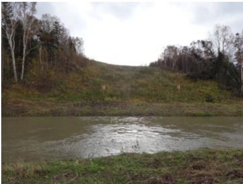
Фото 3. Вид в южном направлении через реку на западный берег и склон ПО.
