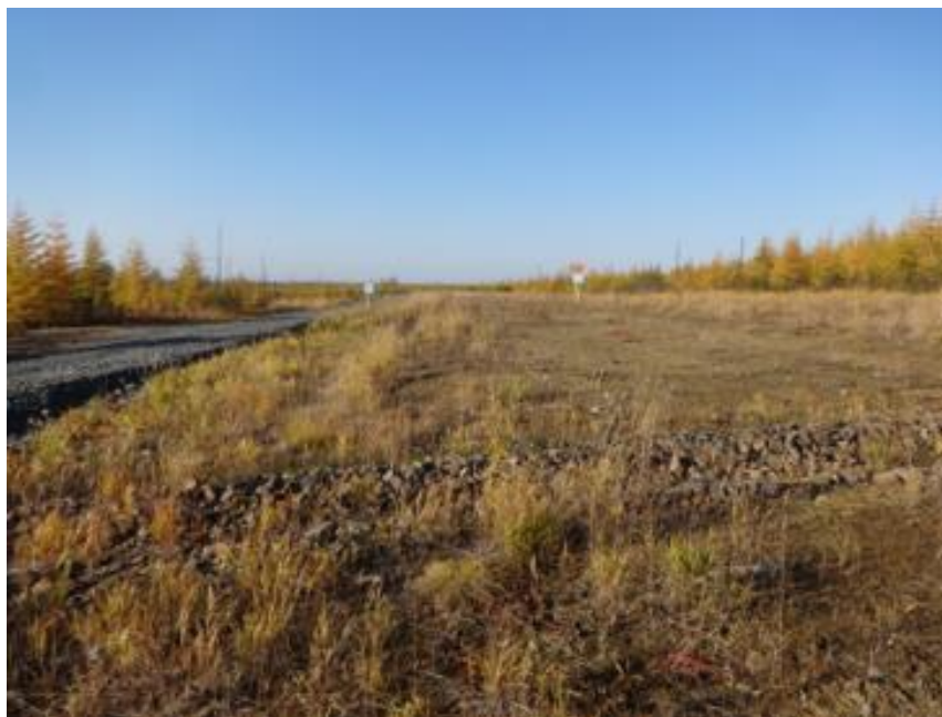
Фото 2. Поперечный канал, идущий к водопропускной трубе под подъездной дорогой
