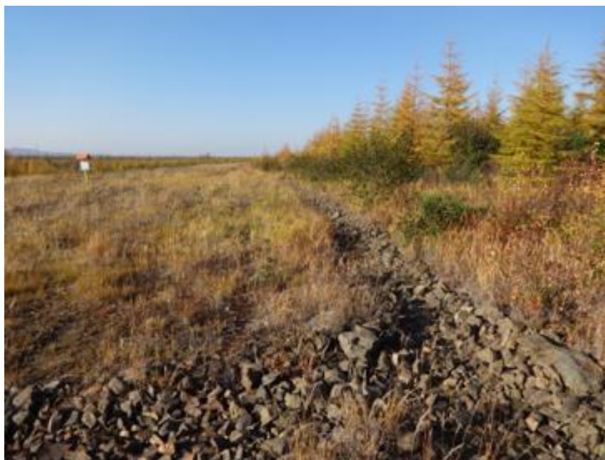
Фото 1. Укрепленный каменной наброской перехватывающий канал, соединяющийся с поперечным каналом
