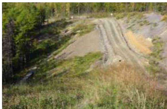
Фото 1. Вид на север: хорошо укрепленные склоны с достаточным растительным покровом.
