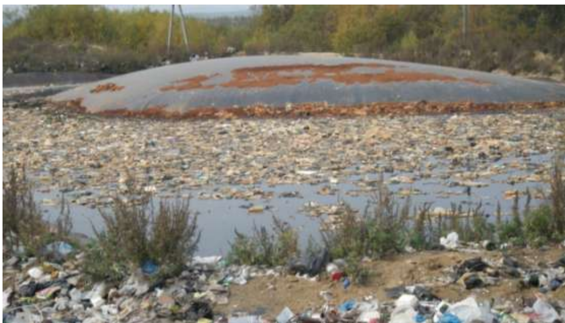
Фото 38. Пузырь, образовавшийся в муниципальном отстойнике для фильтрата
