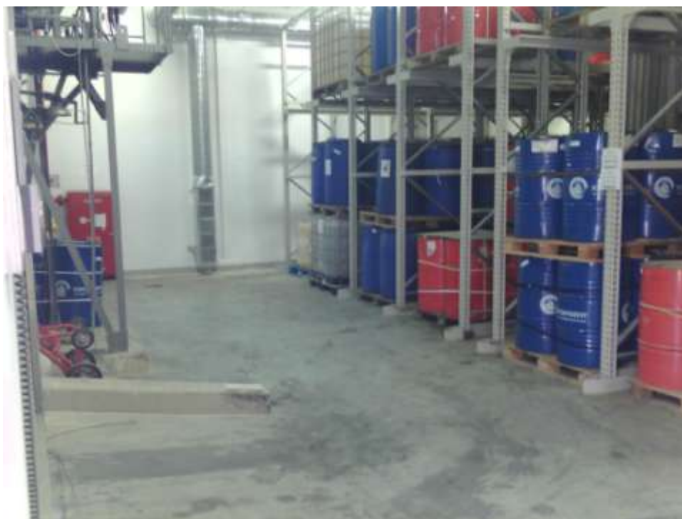
Фото 32. Здание для хранения смазочных масел с уклоном в зону вторичной оболочки
