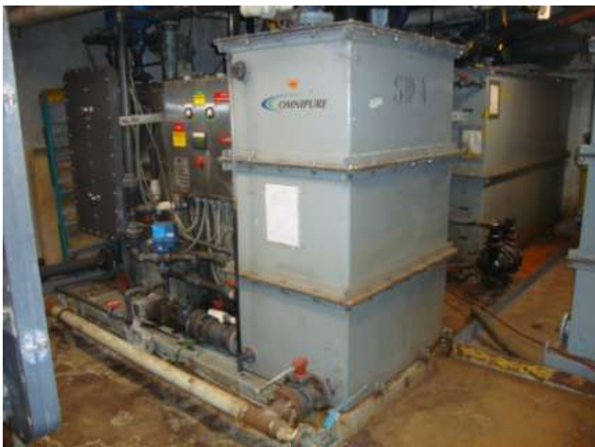
Фото 4. Установка очистки сточных вод «А» Блок «В» сзади, новый блок «С» справа
