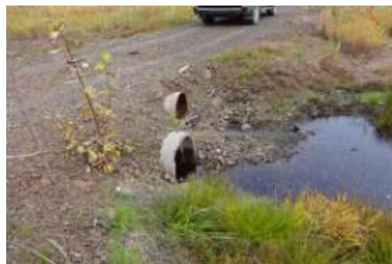
Фото 6. Вид на отремонтированную водопропускную трубу(-ы) на заболоченном участке, пересекающем подъездную дорогу на NOB-24.
