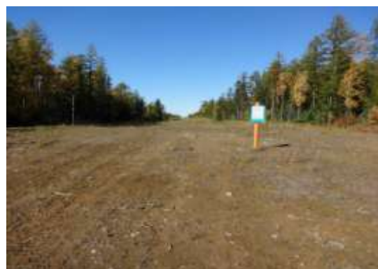
Фото 2. Вид на юг: ПЗ, частично покрытая растительностью. Обратите внимание на следы тяжелого оборудования, повредившего поверхность ПЗ.
