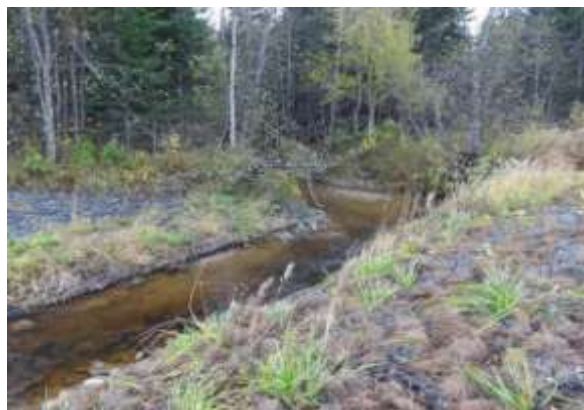
Фото 2. Вид вверх по течению: укрепленные берега и напочвенный покров на матрацах Рено.
