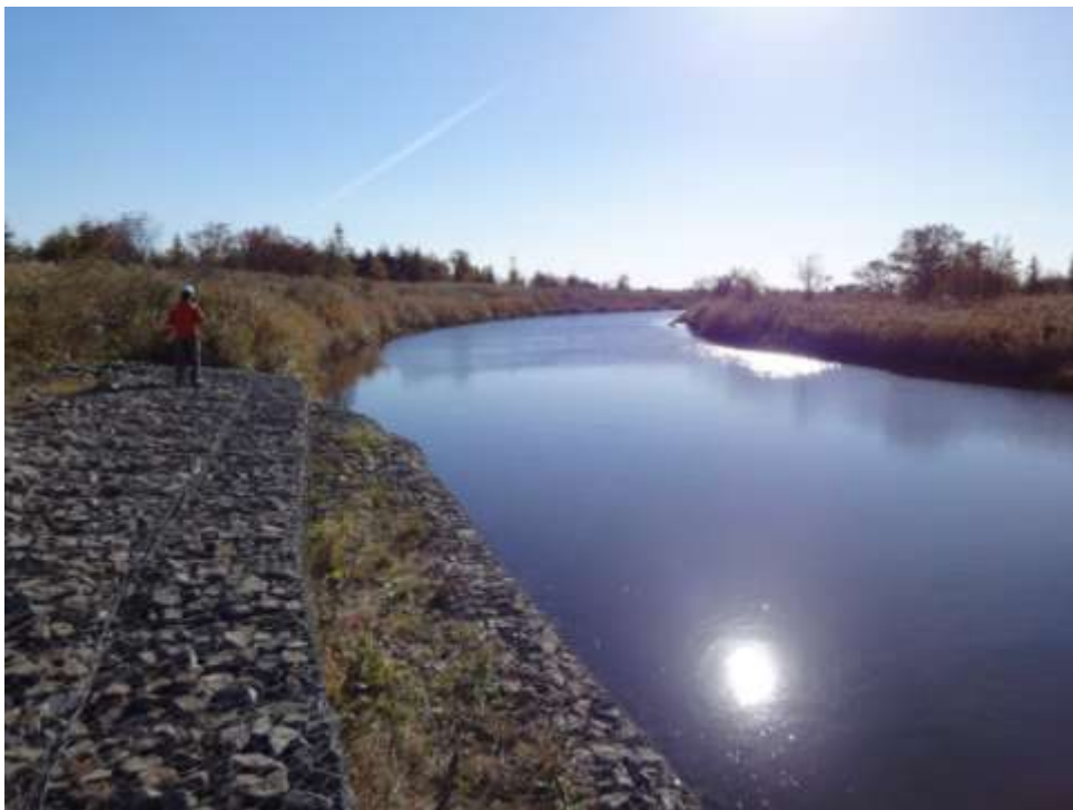
Фото 27. Габионовая стена на южном берегу р. Мануй
