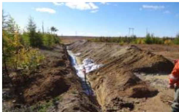
Фото 1. Вид на запад, в сторону НОВ-12: идут восстановительные работы.
