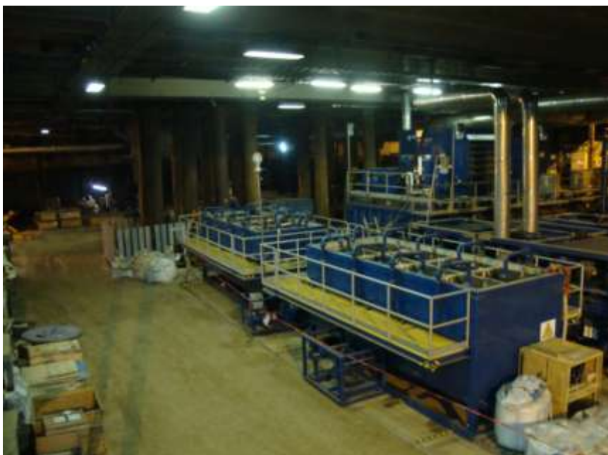
Фото 3. Вытяжная вентиляция, закрепленная на оборудовании в зоне «ядра»
