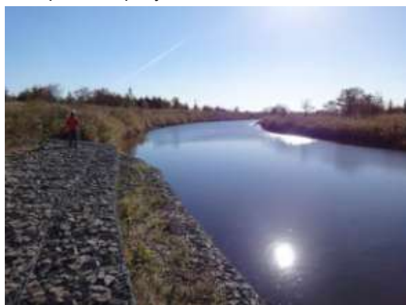
Фото 1. Вид вниз по течению: габионы на северном берегу.
