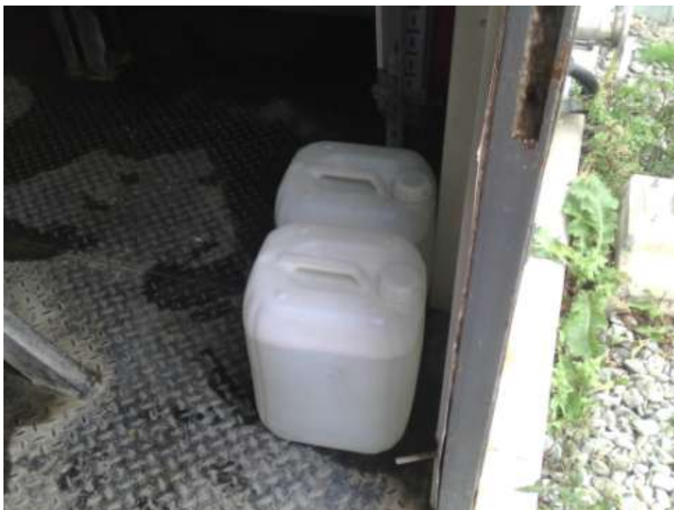
Фото 33. Контейнеры с неизвестным веществом на установке очистке сточных вод без вторичной защитной оболочки или ИЛБМ
