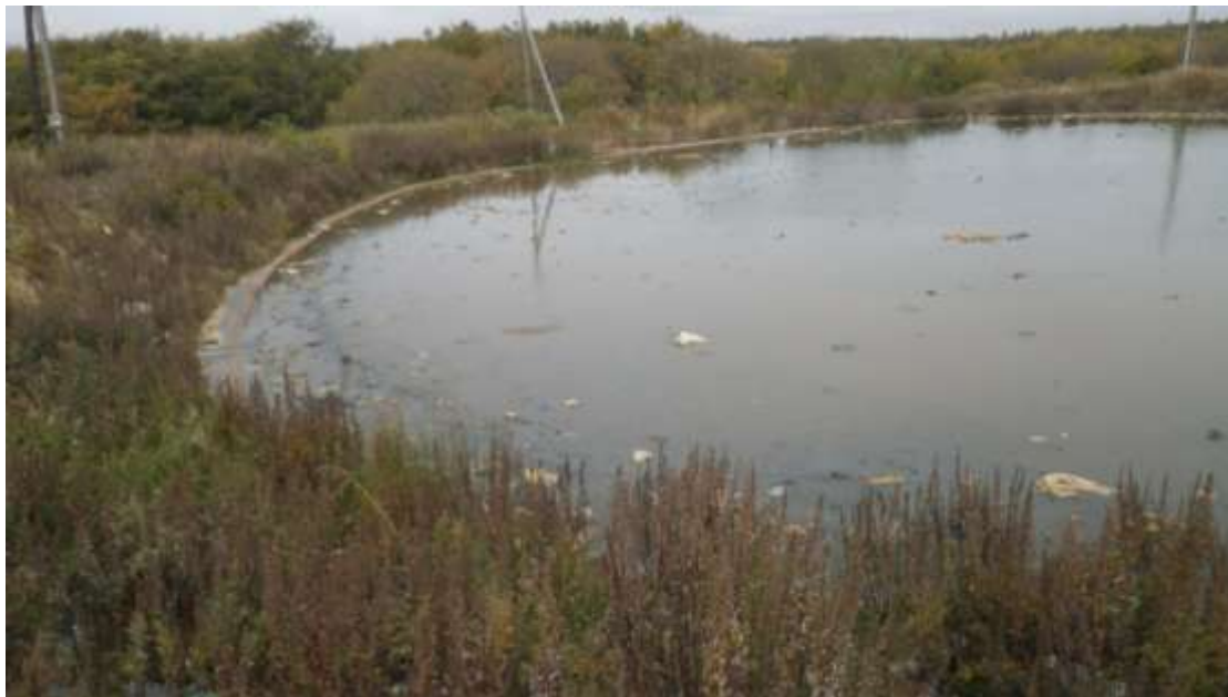
Фото 37. Переполнение отстойника для фильтрата
