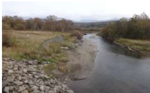
Фото 1. Вид вниз по течению: матрацы Рено на северном берегу и немного подмытые матрацы на южном.
