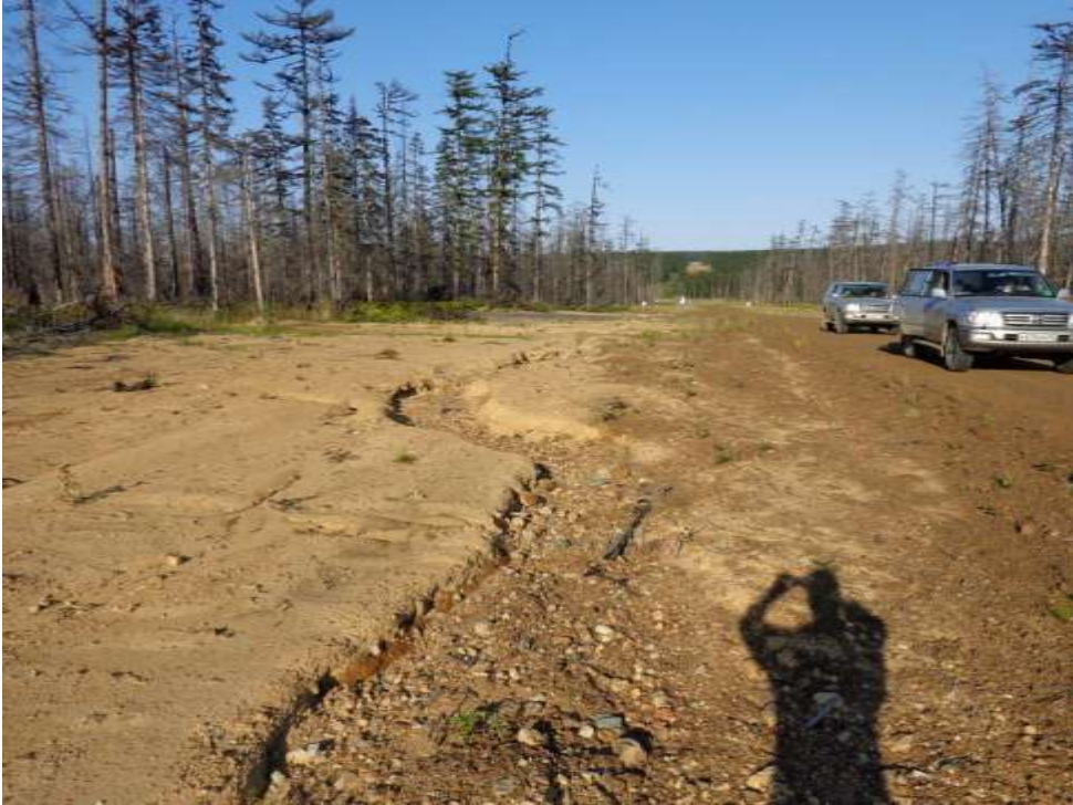
Фото 21. ПЗ у КП 15 в сентябре 2012 года с развивающейся эрозией
