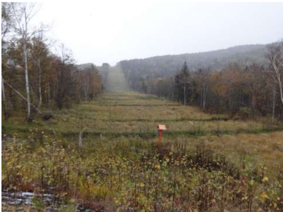
Фото 23. Склоны на реке Девятая (КП 178) с плотным растительным покровом на раскатыелях склона, укрепленных геоджутом
