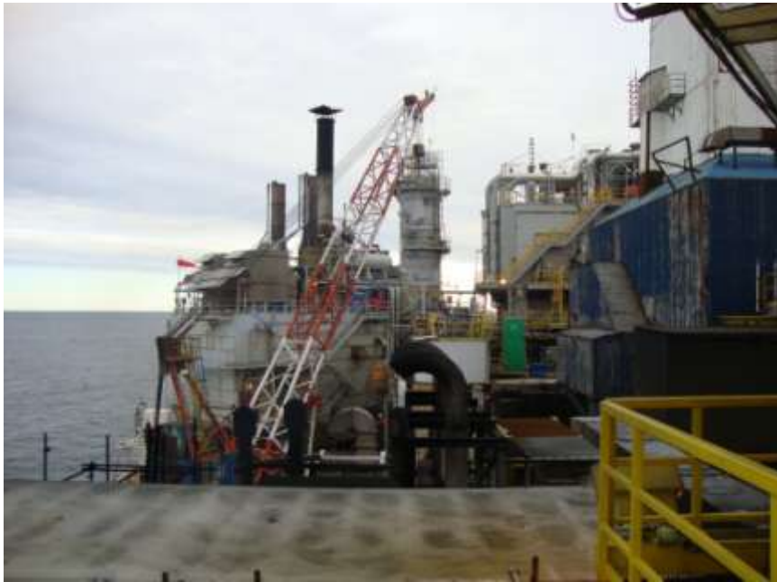
Фото 1. Выхлопные трубы генератора и компрессора
