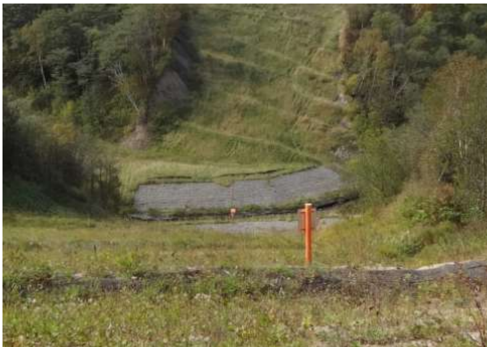
Фото 26. Река Кринка с хорошим восстановленным растительным покровом и излишними противоиловыми заграждениями
