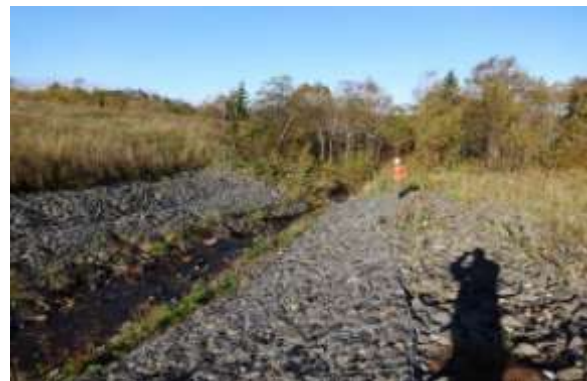
Фото 4. Конструкция сезонного дренажного канала и хороший растительный покров.
