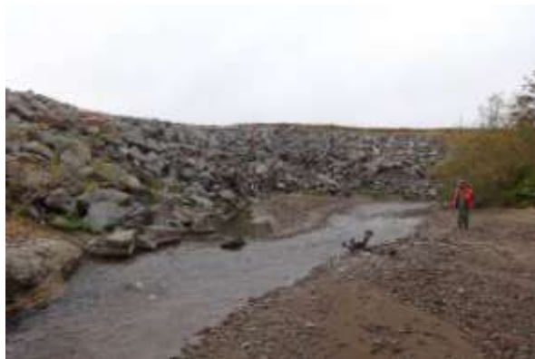
Фото 3. Вид вверх по течению с ПЗ: укрепление берега крупной каменной наброской.
