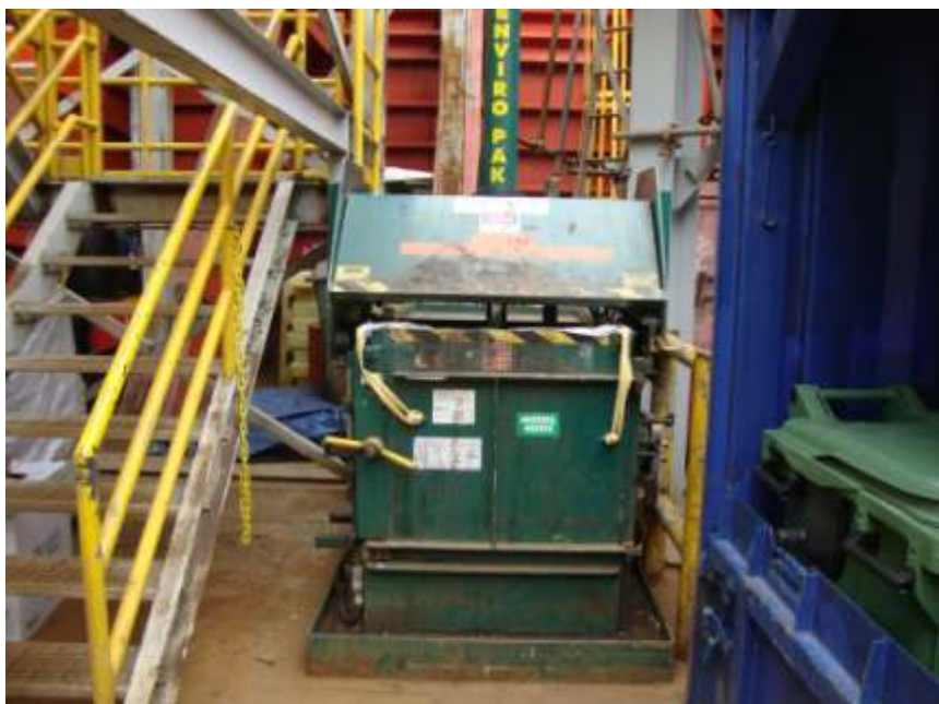
Фото 5. Устройство для спрессовывания отходов пластмассы на главной палубе
