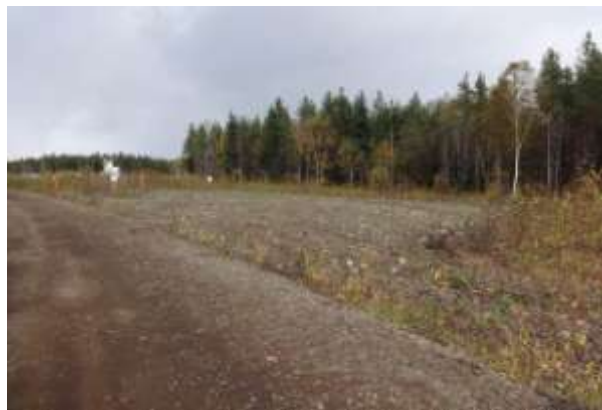
Фото 1. Вид на площадку проведения земляных работ.
