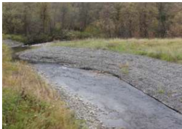
Фото 1. Вид вниз по течению: поврежденные матрацы Рено на западном берегу.
