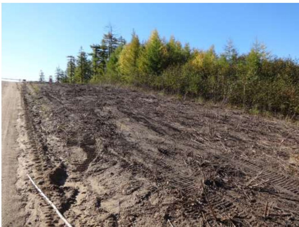
Фото 13. ПЗ после механической рубки деревьев около КП 63
