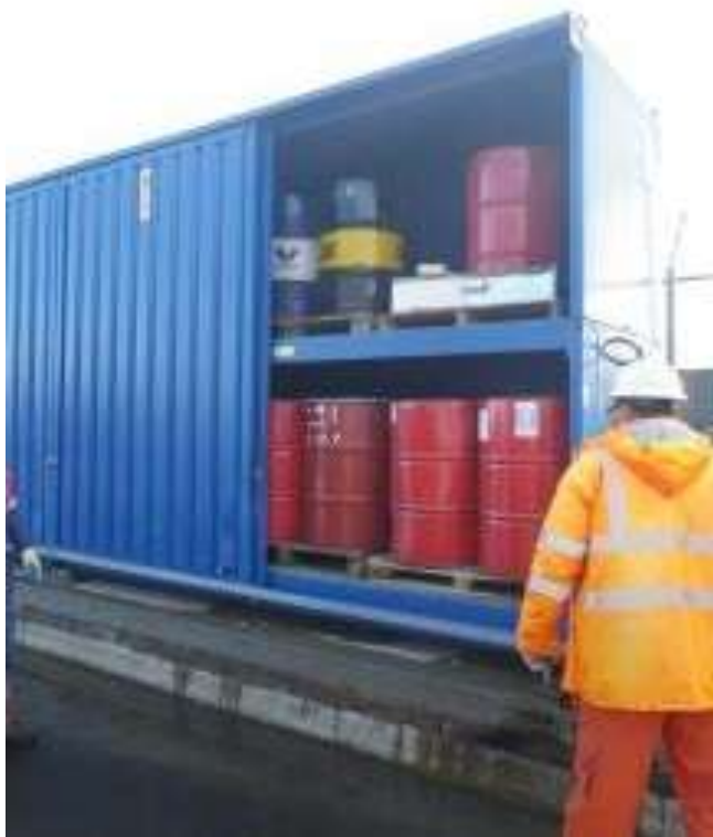
Фото 30. Внешнее хранилище бочек на АВП ОБТК
