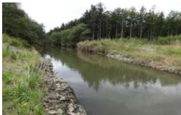
Фото 1. Вид на северный берег: пересечение нефтепровода.
