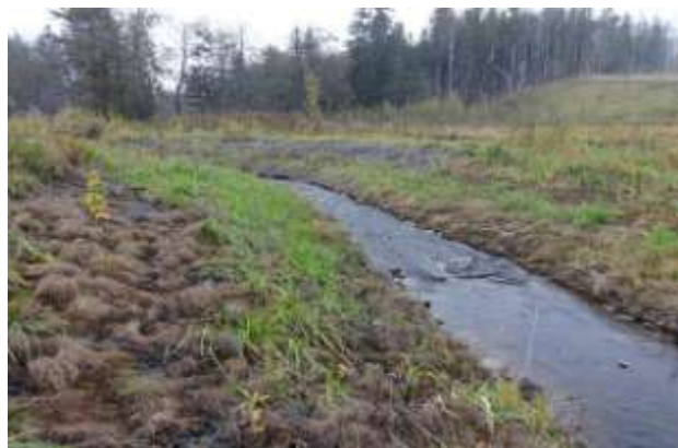
Фото 1. Вид вниз по течению: укрепленные берега и напочвенный покров на матрацах Рено.
