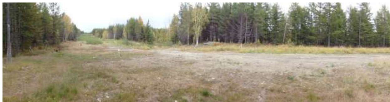
Фото 1. Панорамный вид места проведения земляных работ в ПЗ: поврежденный участок
