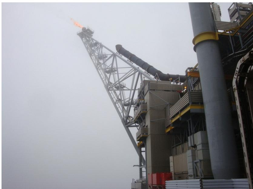
**Фото 7:** Выхлопная труба газового компрессора (прикрепленная к факельной вышке)
