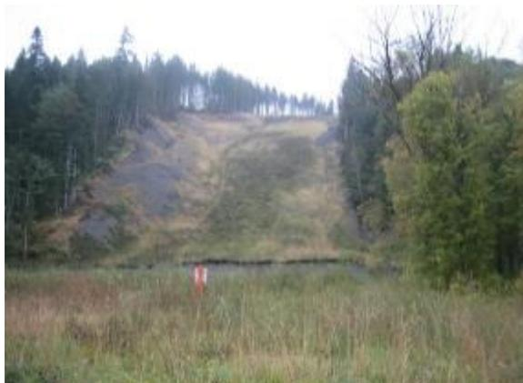
**Фото 4.** Вид на юг: южный склон с хорошим покровом и иловое заграждение, требующее ремонта.
