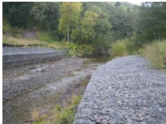
**Фото 3.** Полоса землеотвода: густой растительный покров с обеих сторон перехода и частично непокрытые боковые выемки.
