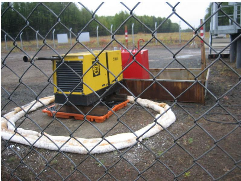
**Фото 12** Временный дизельный генератор и расходный топливный бак на УКЗ PGB4
