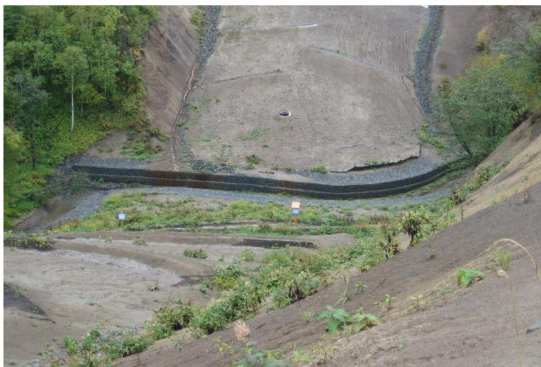
**Фото 4** Пример поврежденного и отсутствующего илового заграждения на склоне с отсутствием растительности или ее малым количеством – река Кормовая (КР – 351)
