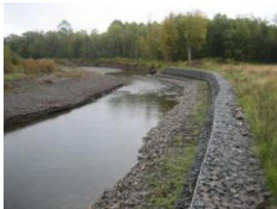
**Фото 3.** Склон после ремонтных работ: удовлетворительный растительный покров на полосе землеотвода.
