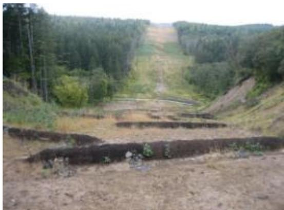
**Фото 2.** Вид на юг: полоса землеотвода с плохим покрытием растительностью и рассекатели склонов после ремонта.
