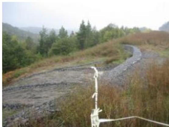
Фото 3. Работы по террасированию и укладке геотекстильного материала.
