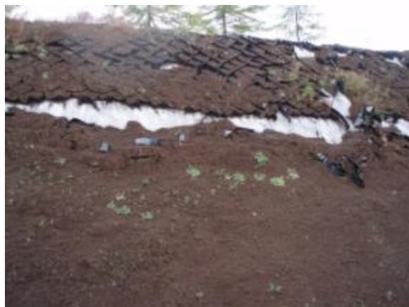
Фото 4. Разрушение боковой выемки
