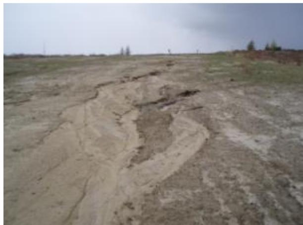
Фото 4. Промоина за рассекателем склонов
