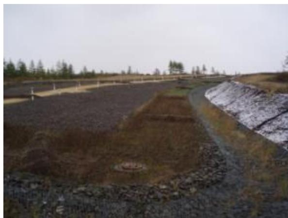
Фото 2. Полоса землеотвода с умеренной рекультивацией и рассекателями склонов
