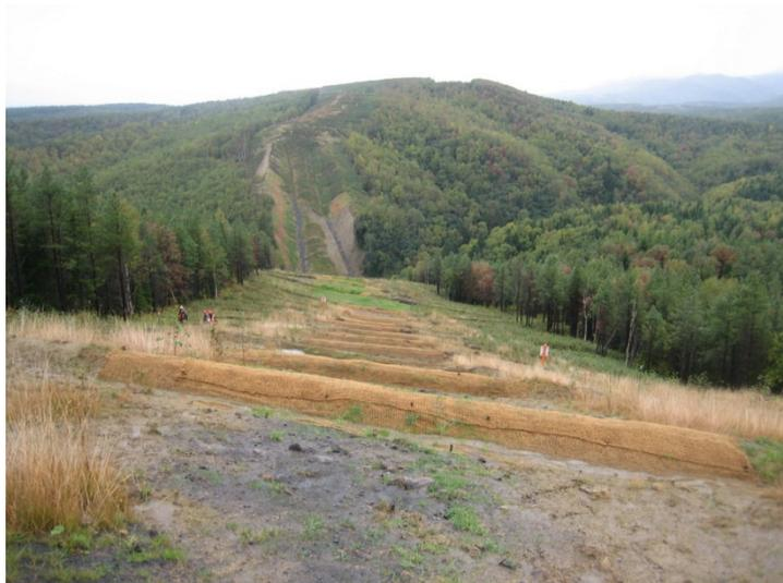
**Фото 1** Отремонтированные рассекатели склонов на подъездной дороге на склоне у реки Гарь
