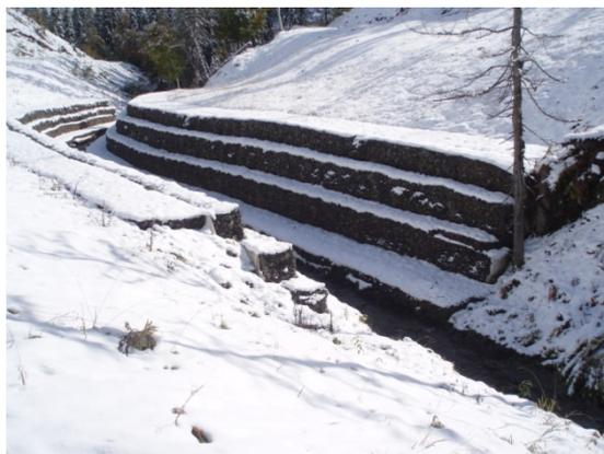
Фото 10 Габионные стенки в хорошем состоянии на ручье Встречный
