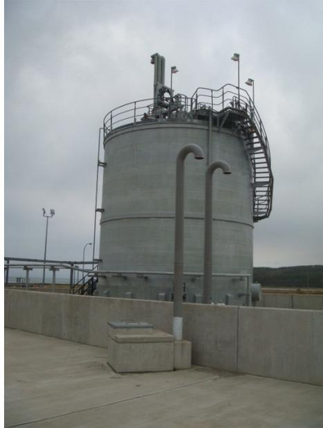
**Фото 7:** Резервуар хранения жидкого теплоносителя
