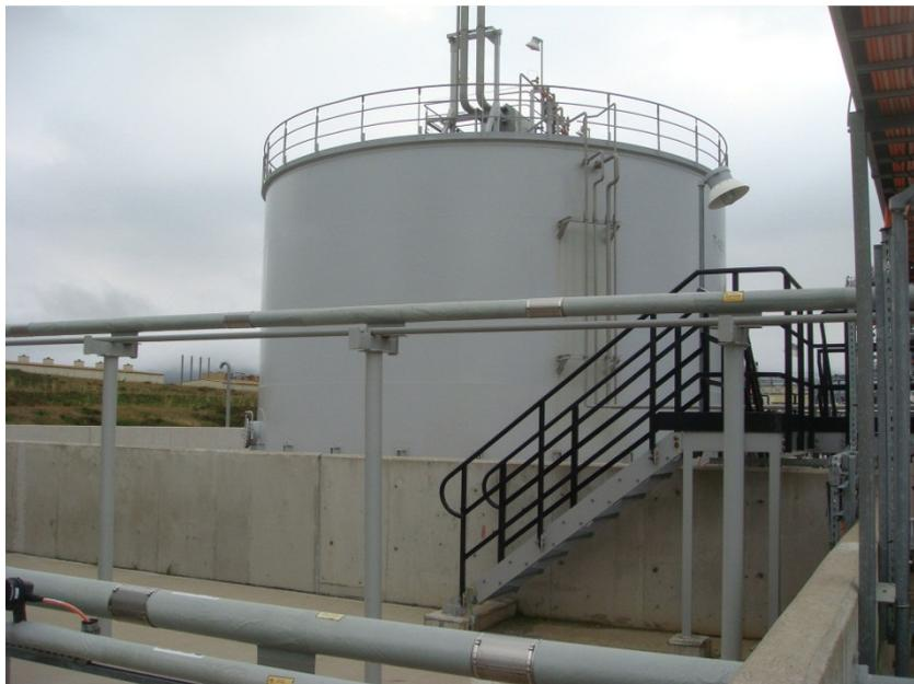
**Фото 6:** Резервуар хранения дизельного топлива
