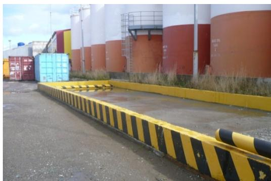
Фото 20 Зона загрузки танкера с обваловкой
