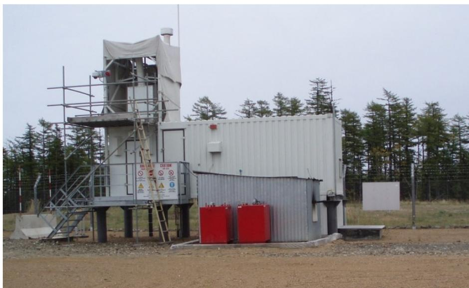
**Фото 13** Временный дизельный генератор и расходный топливный бак на УКЗ NOV17
