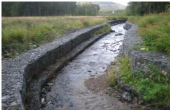
**Фото 2.** Вид вверх по течению реки до водного перехода на участке, где начинаются габионы. Видна недавно уложенная тяжелая каменная наброска.
