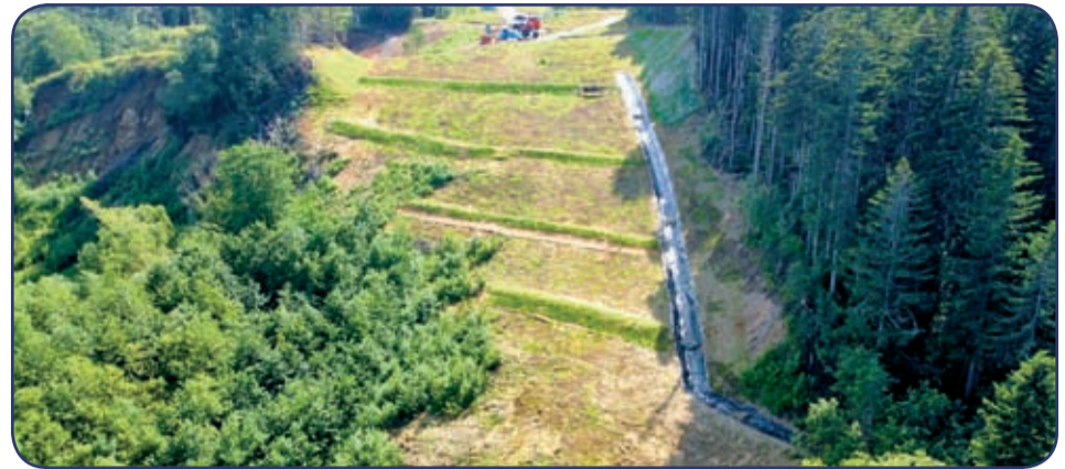
Стабилизация оползневого процесса на трассе наземных трубопроводов
