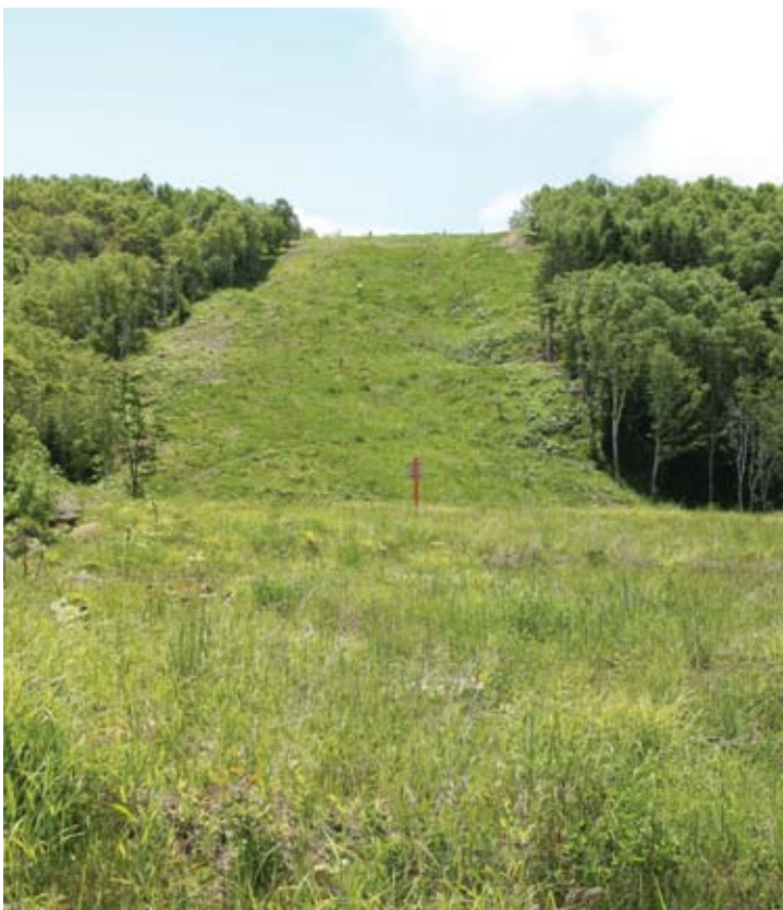
Полоса землеотвода под трубопроводы компании
