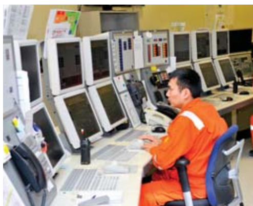
Центральный пункт управления ОБТК
