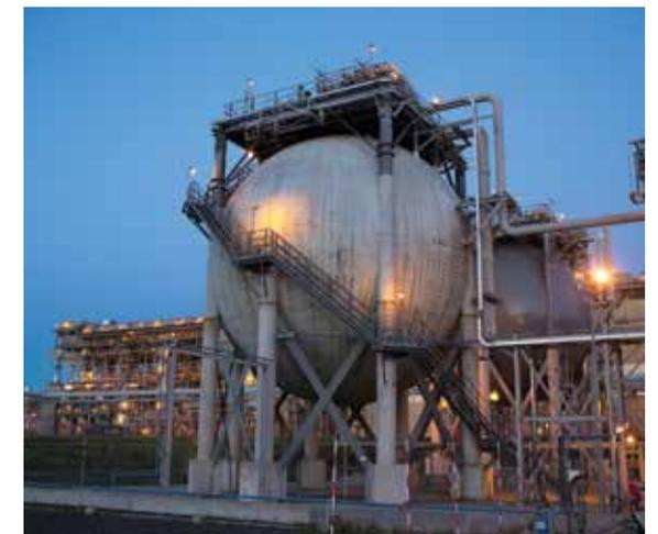
на технологических линиях для охлаждения газа до температуры  $-162\text{ }^{\circ}\text{C}$ : при такой температуре газ переходит в жидкое состояние и уменьшается в объеме в 600 раз.
